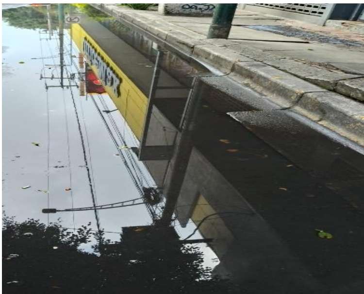
Figura 10. Encharcamiento por deficiencia en el sistema de drenaje, Fuente: elaboración propia
