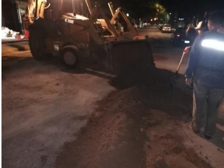
Figura 53. Relleno de zanja en capas de 30 cm compactada. Fuente: elaboración propia
