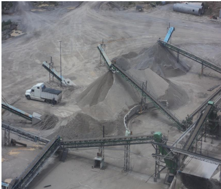
Figura 37. Verificación del banco de arena. Fuente: elaboración propia
