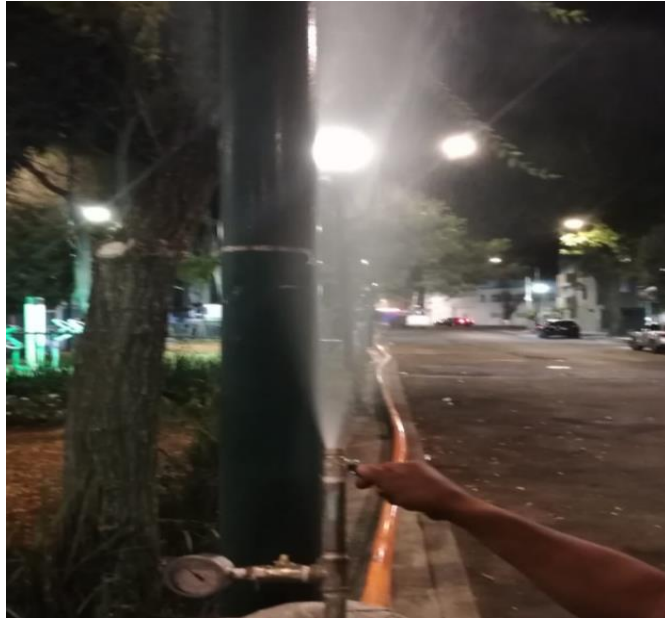
Figura 45. Proceso de desfogue una vez concluida la prueba hidrostática. Fuente: elaboración propia
