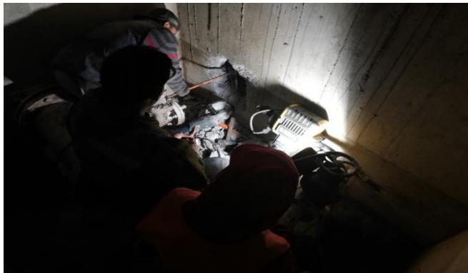
Figura 18. Obra de conducción demolición para paso de tubería. Fuente: elaboración propia
