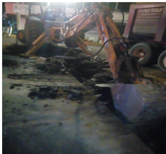
Figura 33. Proceso de excavación. Fuente: elaboración propia
