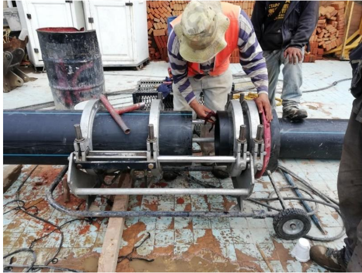
Figura 39. Chequeo de cantos de tubería de PEAD RD17 de 12" antes de iniciar con el calentamiento. Fuente: elaboración propia
