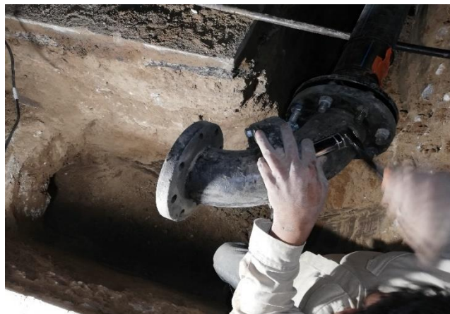
Figura 17. Obra de conducción ensamble de piezas especiales tales como codos de 90°, juntas de neopreno y tornillería. Fuente: elaboración propia
