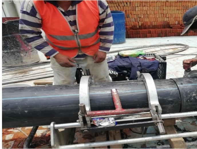
Figura 41. Alineamiento de tubería de PEAD RD17 de 12" antes de iniciar con el calentamiento Fuente: elaboración propia
