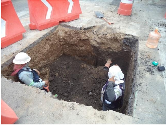
Figura 83. Excavación para caja de válvulas. Fuente: elaboración propia
