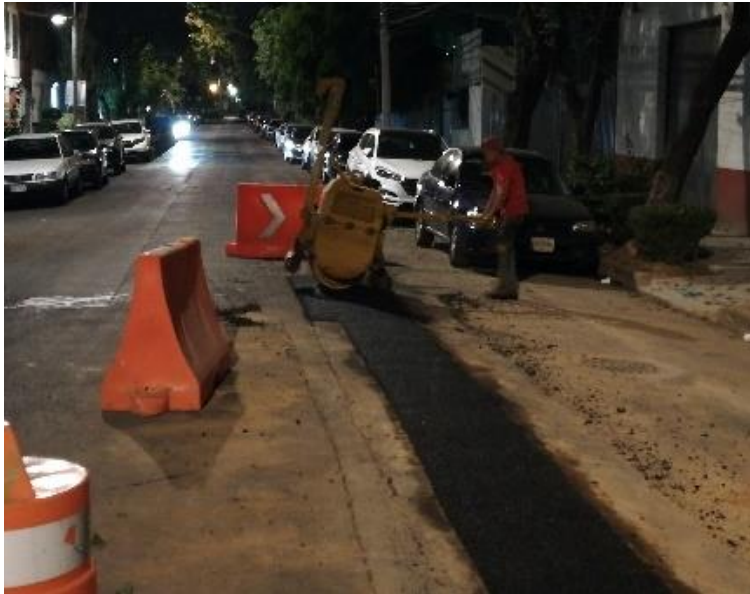
Figura 76. Compactación de carpeta asfáltica. Fuente: elaboración propia
