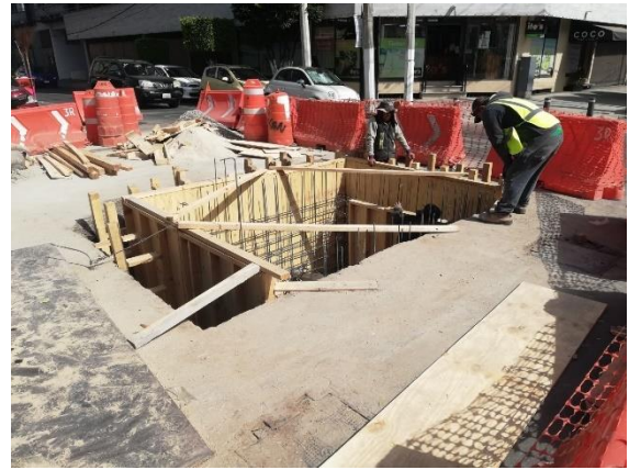
Figura 84. Armado y cimbrado de muros, Fuente: elaboración propia
