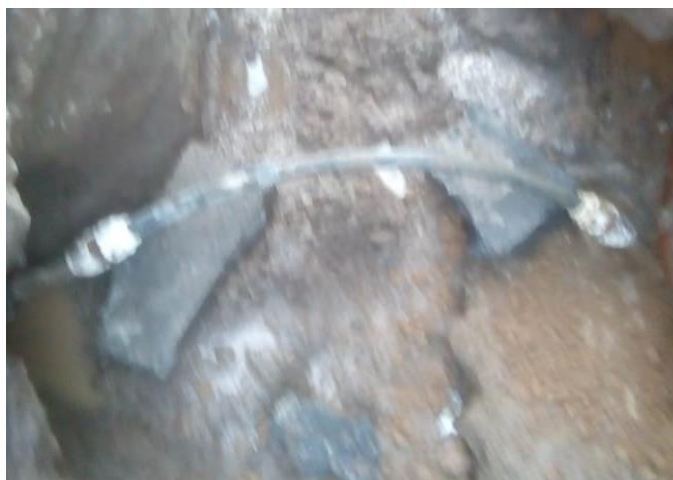
Figura 28. Reparación de tomas domiciliarias de ½" de suministro de agua potable con coples de reparación en ambos extremos y tramos de tubería dependiendo el desarrollo dañado.
