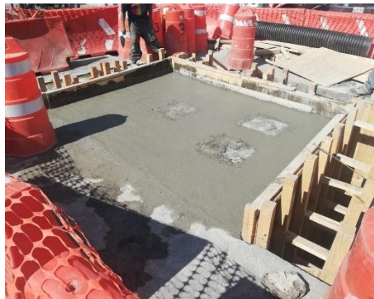
Figura 87. Colado de muros y losa tapa de manera monolítica. Fuente: elaboración propia
