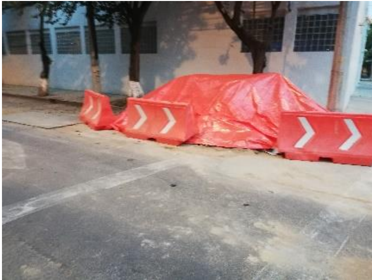
Figura 51 Almacenamiento de material de relleno a pie de obra. Fuente: elaboración propia
