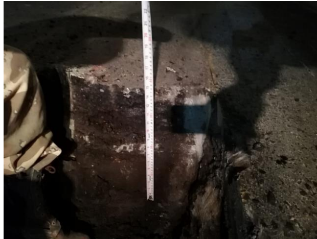
Figura 31. Evidencia de espesor de carpeta asfáltica. Fuente: elaboración propia.
