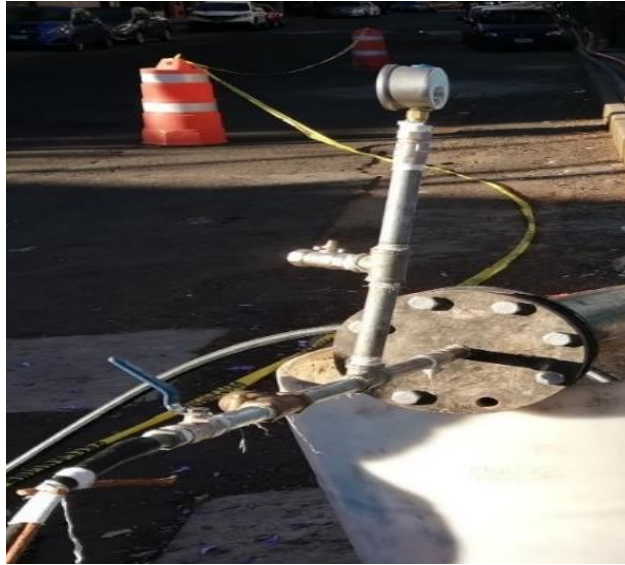
Figura 43. Arreglo del sistema de prueba hidrostática que consta de arreglo de tubería galvanizada, tapa ciega con barreno, tapa ciega, válvula de esfera y sistema de llenado a presión. Fuente: elaboración propia
