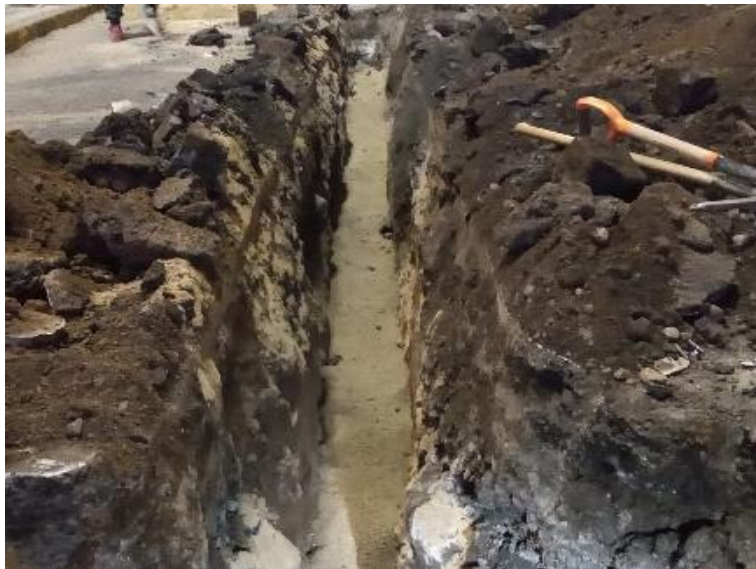
Figura 48. Colocación de cama de arena para recepción de tubería Fuente: elaboración propia
