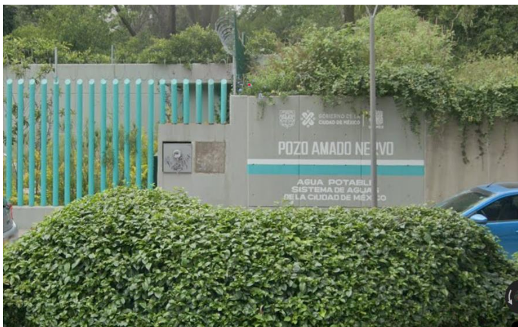
Figura 88. Pozo Amado Nervo, construido para colaborar en el reforzamiento hidráulico. Fuente: elaboración propia
