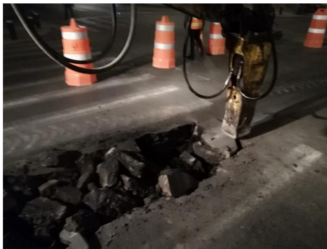
Figura 29. Demolición de carpeta existente. Fuente: elaboración propia
