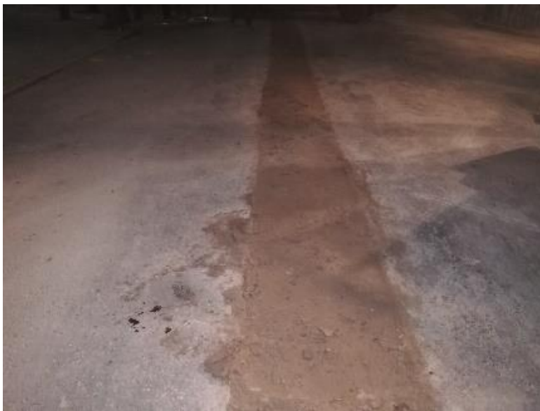
Figura 52. Relleno de zanja en capas de 30 cm compactada. Fuente: elaboración propia
