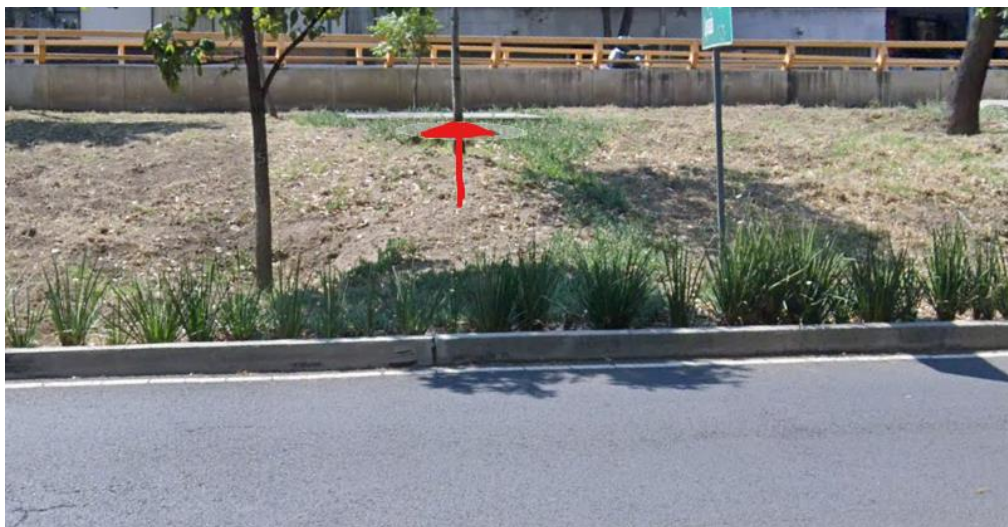
Figura 89. Caja de interconexión de agua tratada Rio Mixcoac entre calle 2 y calle moras. Fuente: elaboración propia
