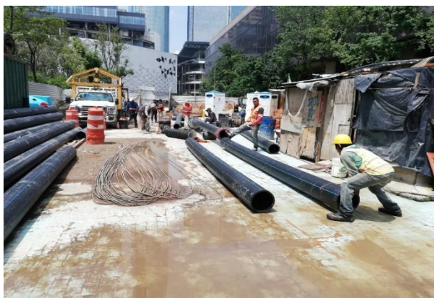
Figura 38. Revisión y almacenaje de tubería de PEAD RD17 de 12". Fuente: elaboración propia
