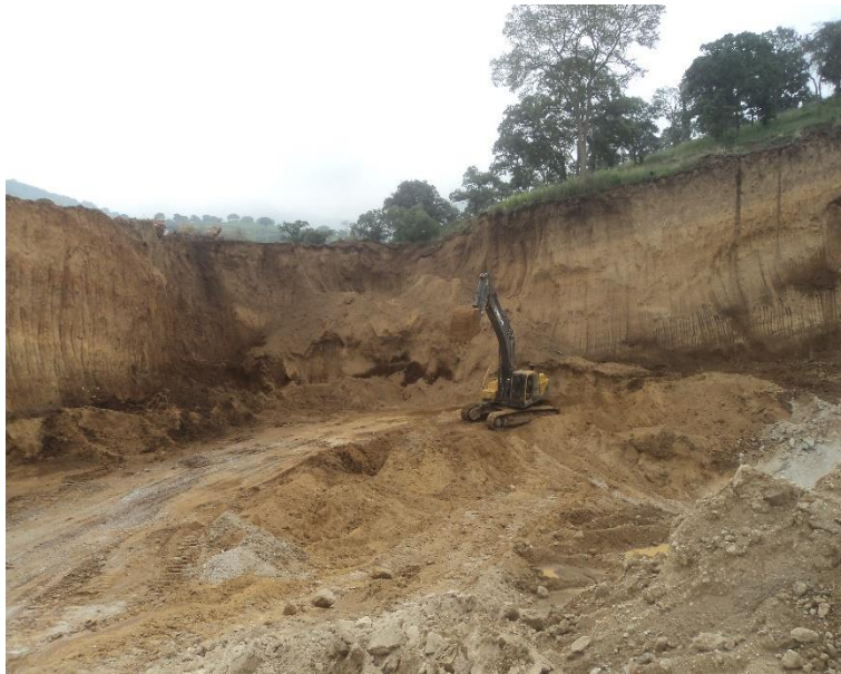
Figura 35. Verificación del banco de tepetate. Fuente: elaboración propia
