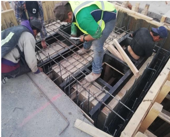
Figura 85. Armado de losa tapa con acero de refuerzo Fuente: elaboración propia
