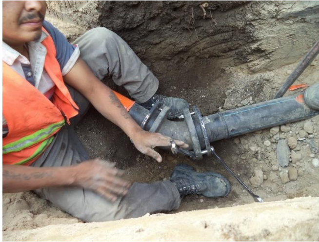
Figura 16. Obra de conducción, ensamble de piezas especiales como tee de fofo, codos de 45° y 90° de fofo, juntas de neopreno y plomo, tornillería, stub end, contrabridas. Fuente: elaboración propia
