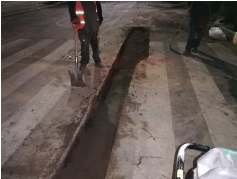
Figura 72. Proceso de cajeo concluido. Fuente: elaboración propia
