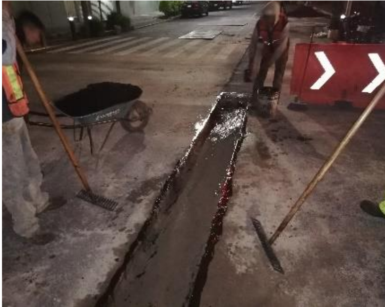
Figura 73. Proceso de riego de liga . Fuente: elaboración propia
