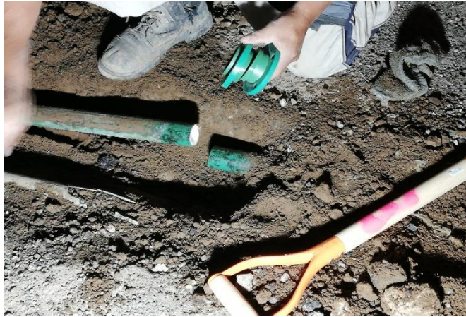
Figura 19. Obra de conducción reparación de tuberías existentes de tubo plus de 2". Fuente: elaboración propia
