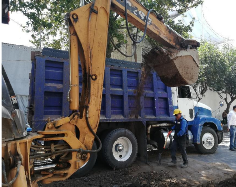
Figura 34. Carga y acarreo de material producto de excavación. Fuente: elaboración propia
