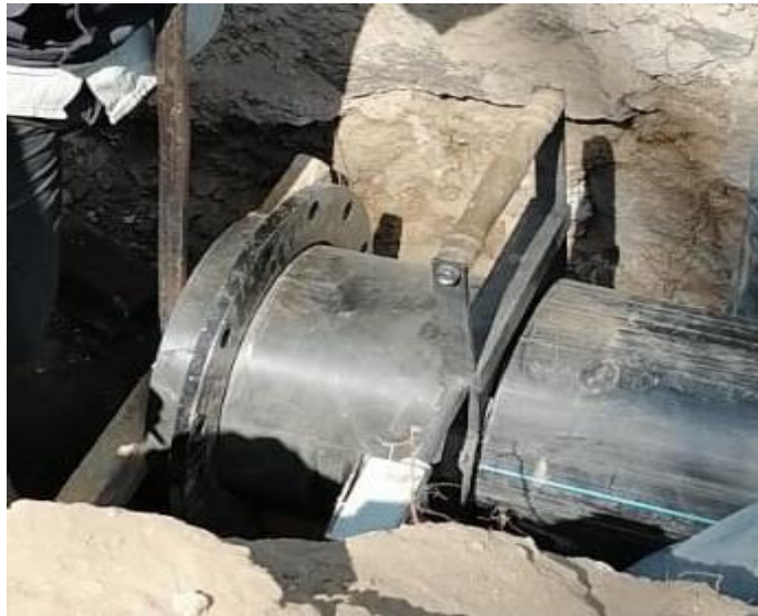
Figura 42. Colocación de plancha de termofusión entre tubería de PEAD RD17 de 12" y stub end. Fuente: elaboración propia
