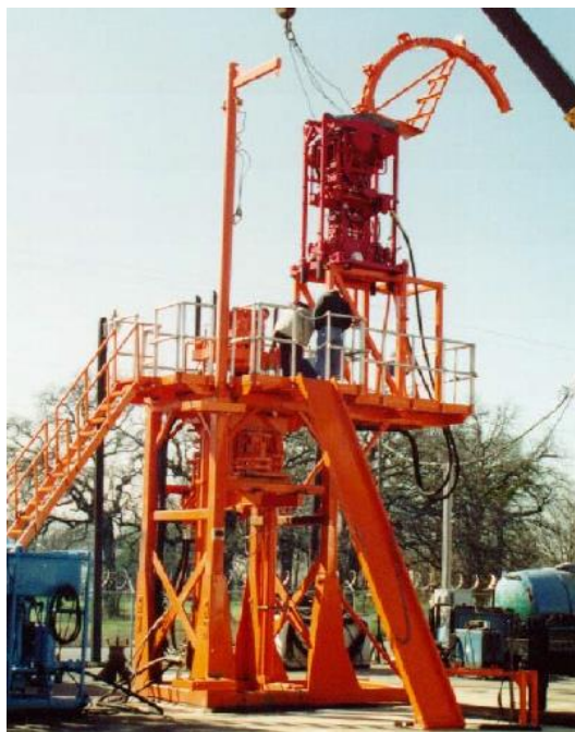
Fig. 4.1 Subestructura con sistema de Jacking.
