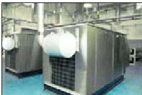
Figura 6.31 Celda de combustible a hidrógeno (Fuente: WWEA, 2006)
