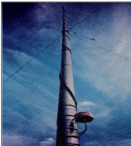
Figura 3.10 Torre de medición de tipo tubular de 50 metros de altura.
