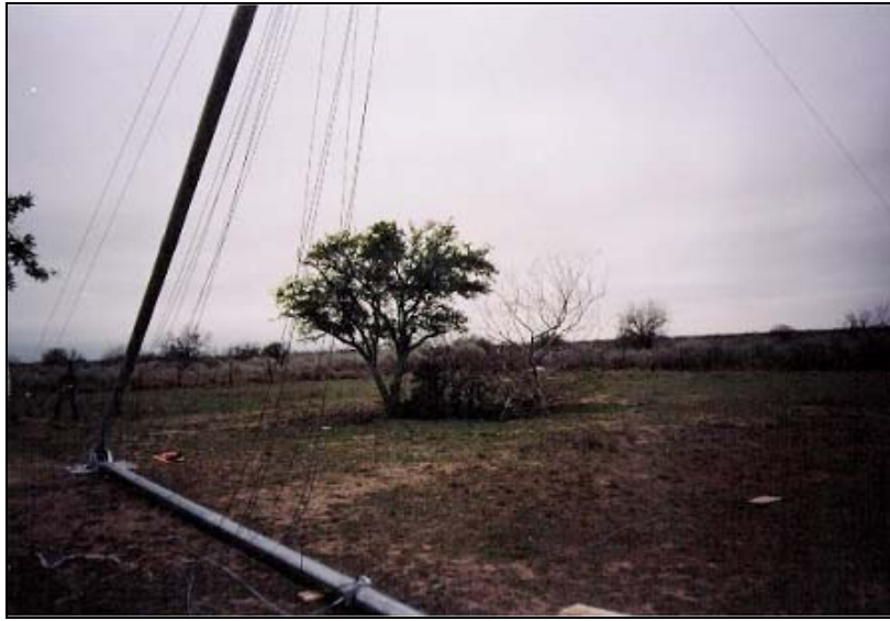
Figura 6.3 Instalación de la torre anemométrica en el sitio
