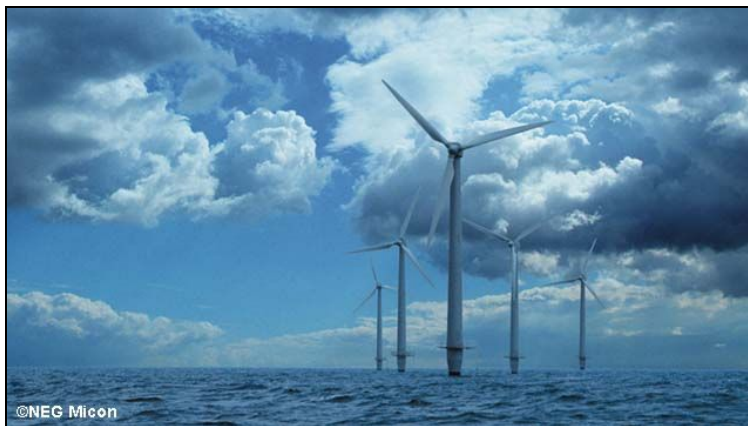
Figura 4.2 Central eoloeléctrica en el mar (offshore)
