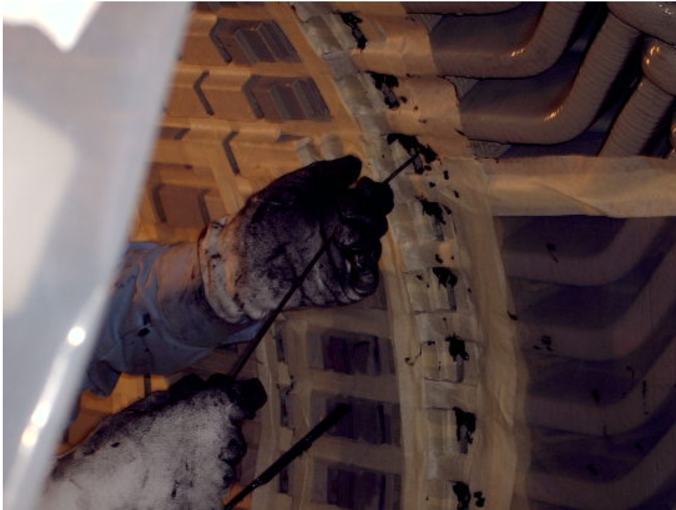
Figura 4.7 Maniobra de la inyección de resina
