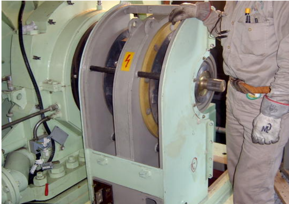
Figura 4.3 Desmontaje del portaescobillas.
