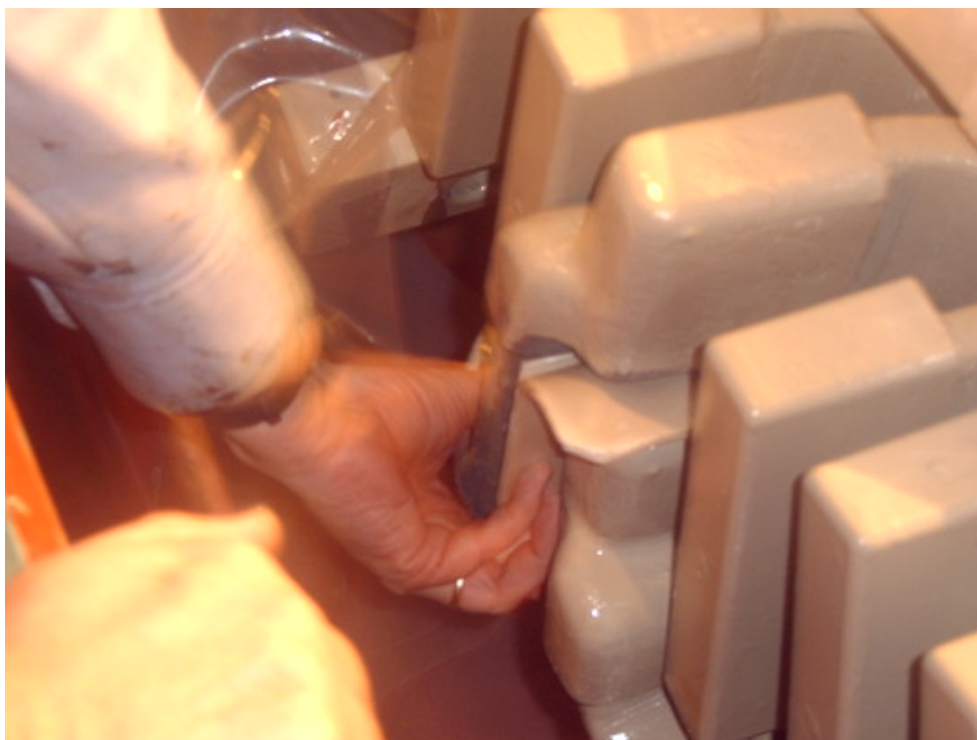
Figura 4.6 Revisión y limpieza del estator
