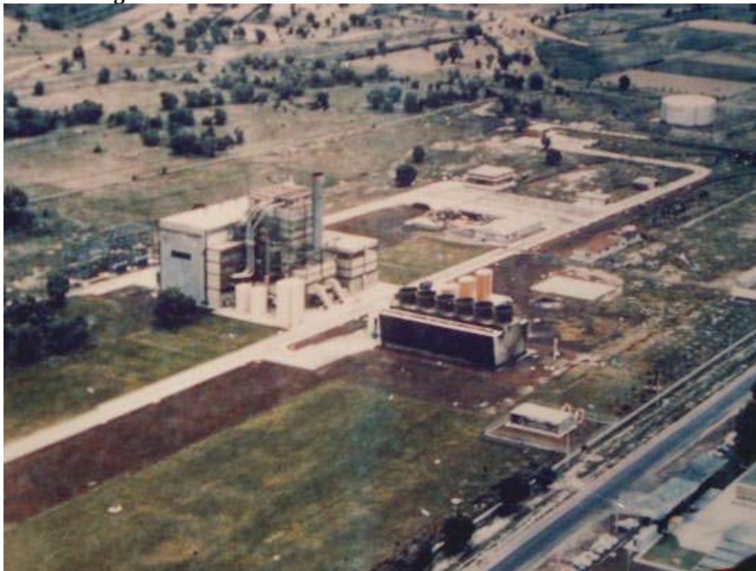
Figura 1.1 Unidad 1 Central Termoeléctrica Valle de México
