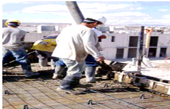
Colado de pretilos
