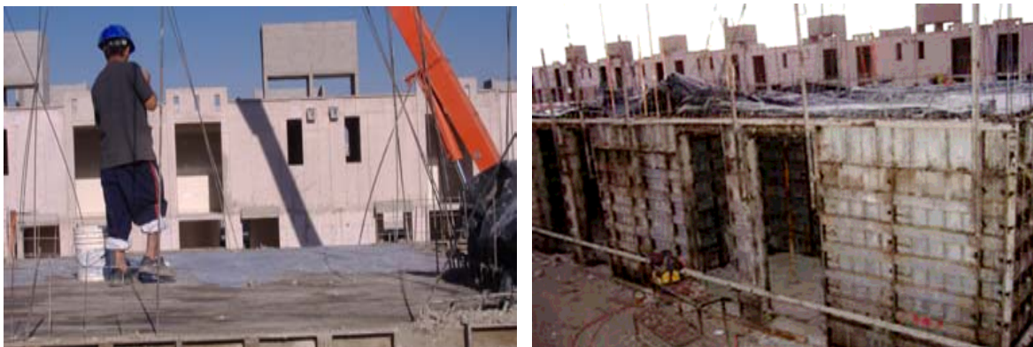
Curado de losa de entrepiso
