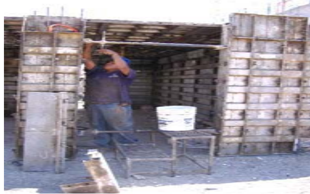
Colocación de gatos
