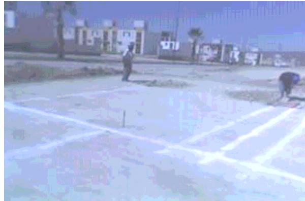
Trazado de cimentación
