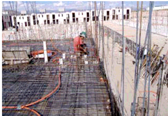
Instalación eléctrica
