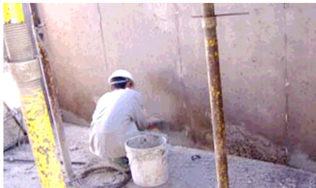
Resane de oquedades
