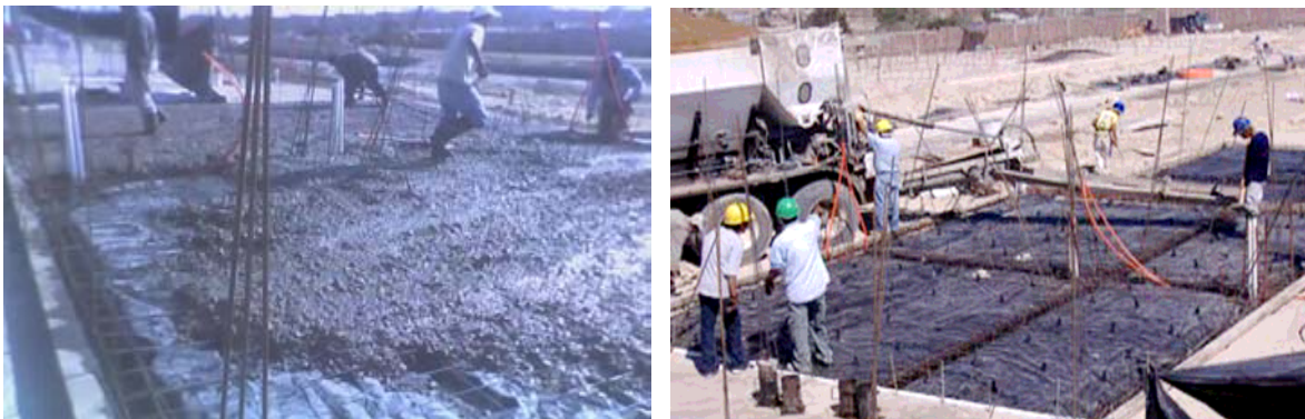
Colocación de concreto
