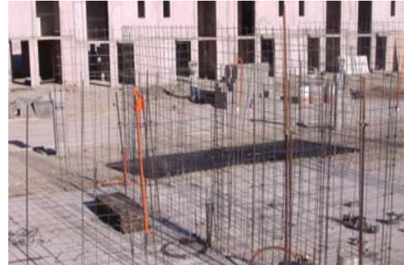
Instalación hidráulica y sanitaria
