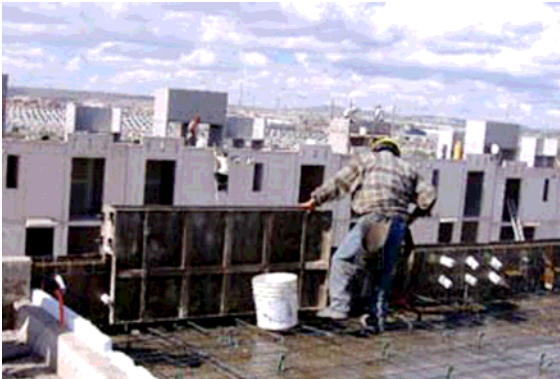
Cimbra en pretilos
