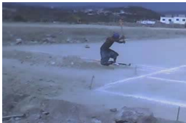
Excavación de cepas
