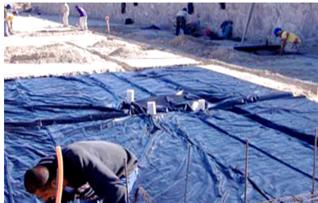
Colocación de plantilla de polipropileno
