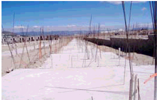
Losas de cimentación
