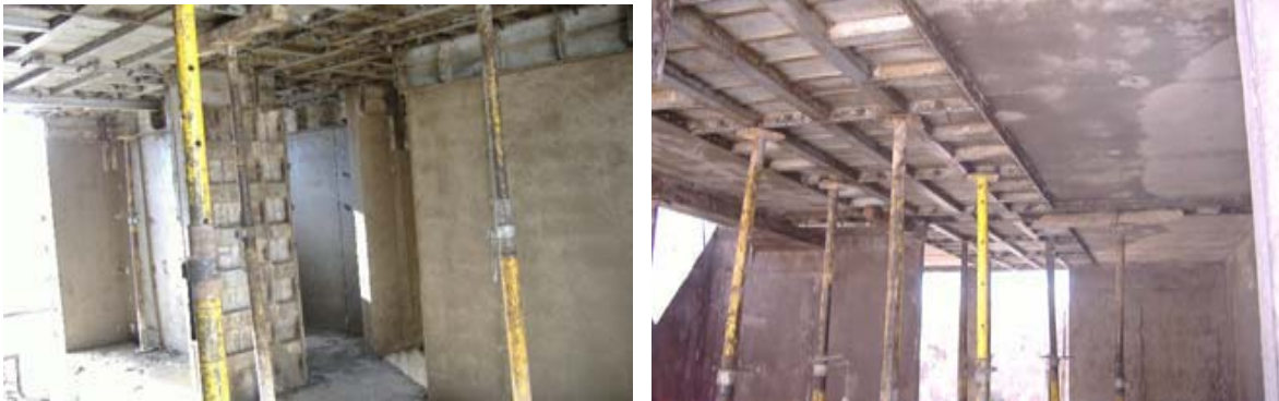
Descimbrado de muros y losa
