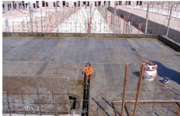
Aplicación de desmoldante
