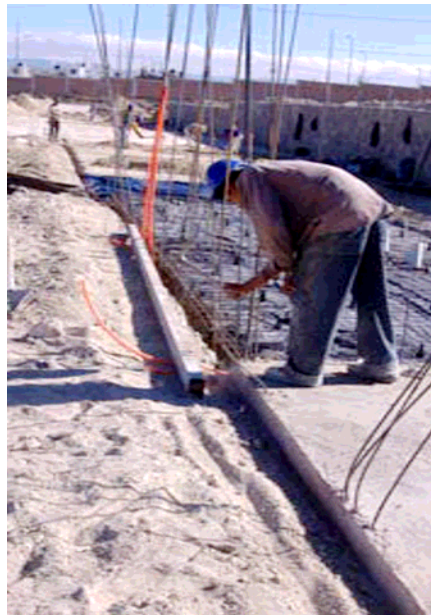
Colocación de cimbra perimetral
