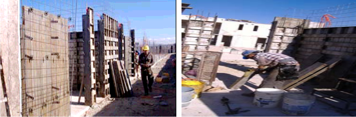
Cimbra en muros
