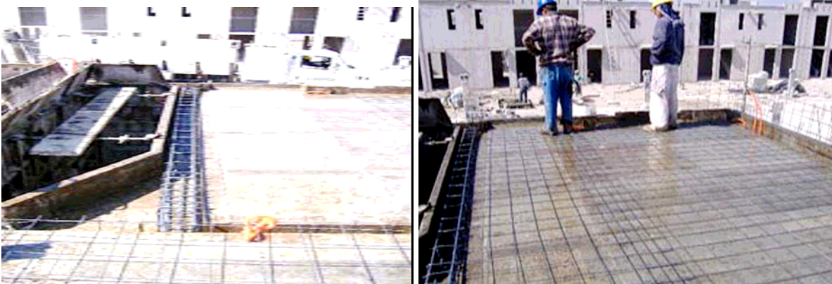
Acero de refuerzo
