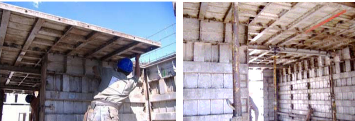
Cimbra en losa de entrepiso
