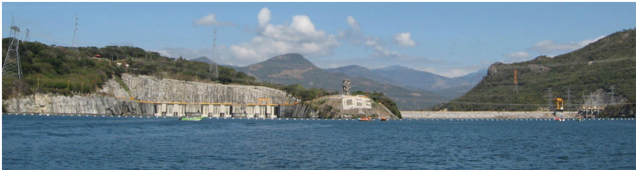
Figura 3.6 Fotografía de la central hidroeléctrica Manuel Moreno Torres
