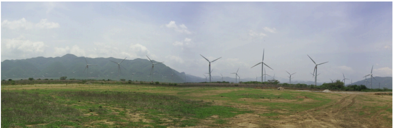
Figura 11.1 Parque eólico La Venta en el istmo de Tehuantepec, en Oaxaca. Es uno de los principales parques eólicos en México desde 1994. La sección más grande genera casi 187 MW, lo cual puede suministrar energía hasta a 200,000 hogares.
