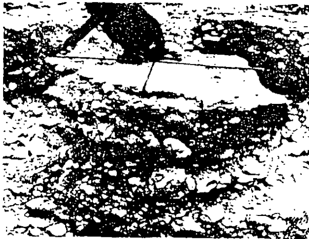
(Fig.2) Columna de 1.50m de diámetro, constituida básicamente por granos gruesos bien graduados con pocos finos, cementada con el sistema "jet-grouting"
