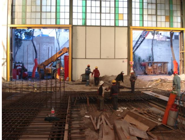
Accesos habilitados en la parte Oeste
