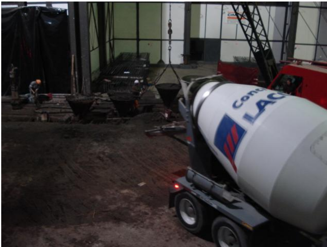
Colado de Paneles del Muro Milán
