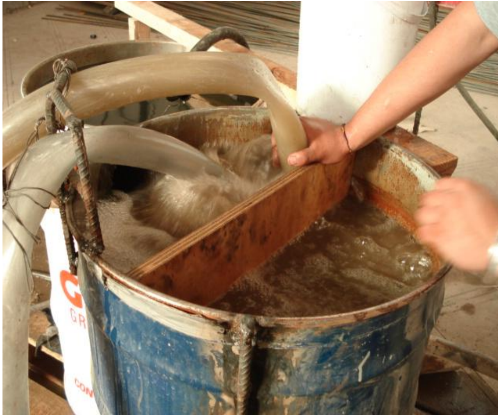
Extracción del agua freática de los pozos
