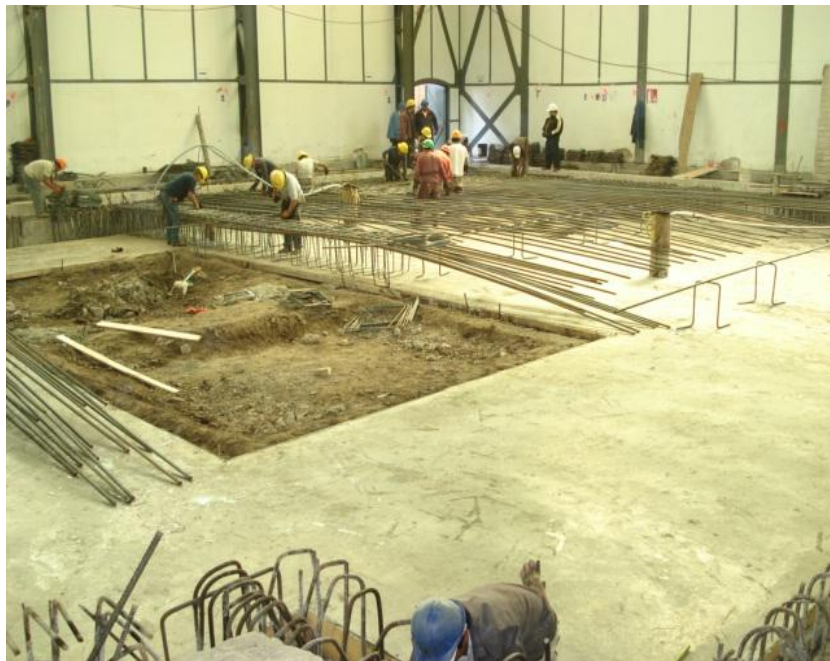
Construcción de la losa Tapa
