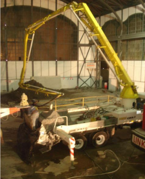
Bombeo de concreto para la losa de fondo.
