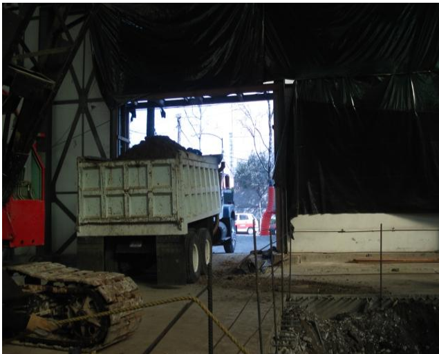
Acceso habilitado en la zona Este
