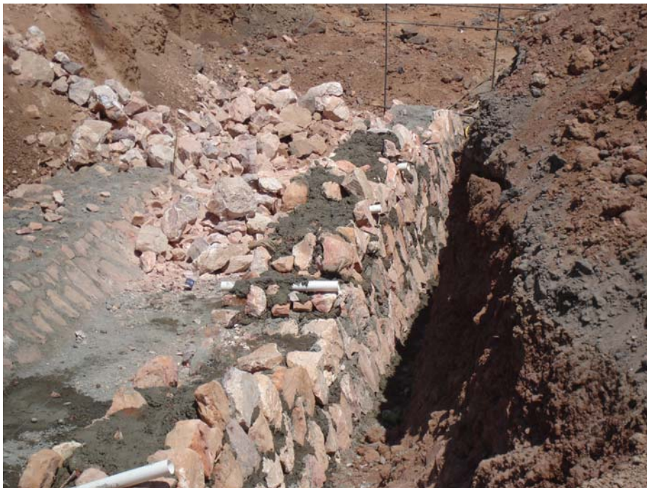
FIGURA 4.27 MURO DE MAMPOSTERÍA PARA PASO GANADERO CON TUBOS DE PVC
