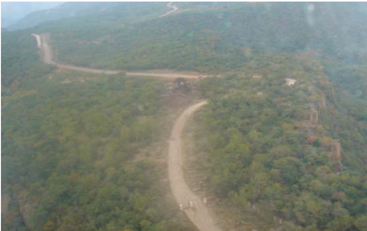
FIGURA 3.11 ESTADO ACTUAL DEL CAMINO DE ACCESO. FOTOGRAFÍA AÉREA SE OBSERVA CURVA MUY CERRADA
