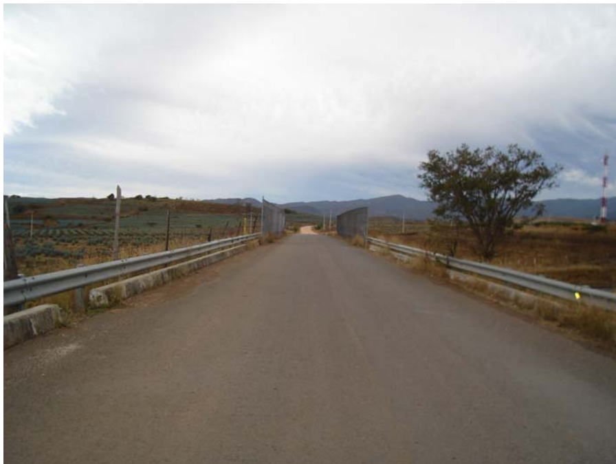
FIGURA 3.3 PUENTE DONDE SE CONECTARÁ EL CAMINO A LA AUTOPISTA
