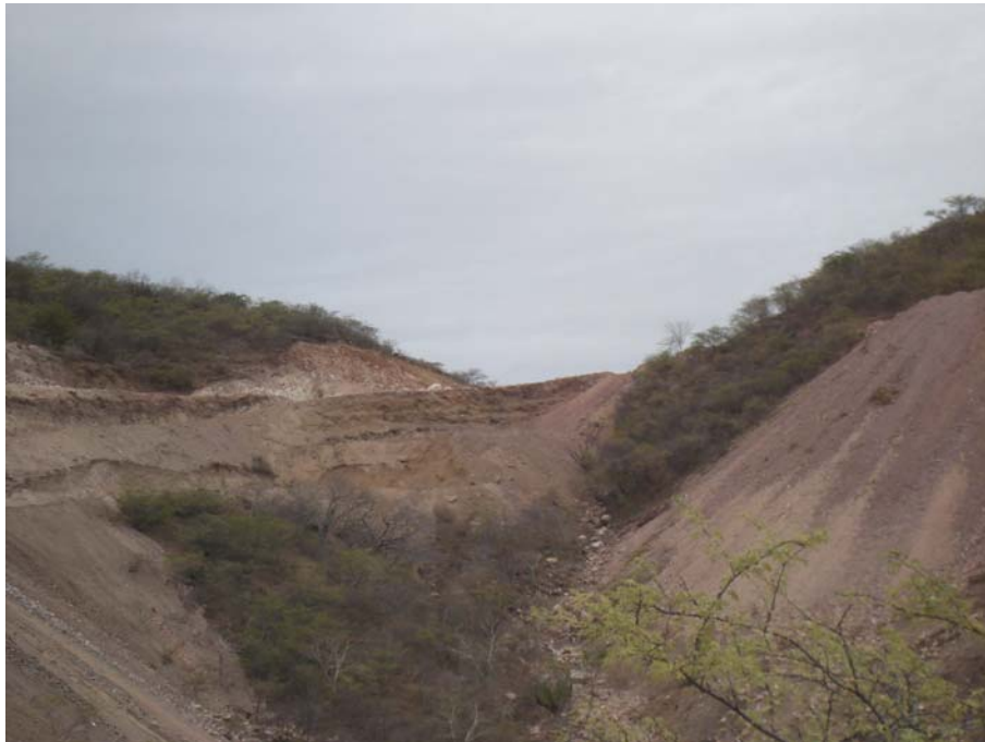
FIGURA 4.17 SE DESPEJA EL ÁREA DONDE SE HARÁN LAS VOLADURAS
