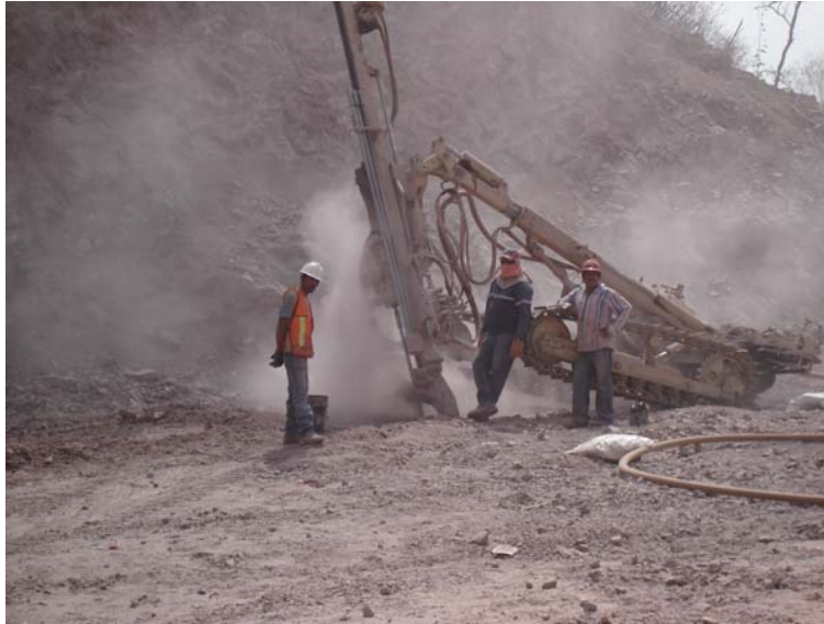
FIGURA 4.12 BARRENADO EN ROCA PARA EL DEPÓSITO DE LOS EXPLOSIVOS
