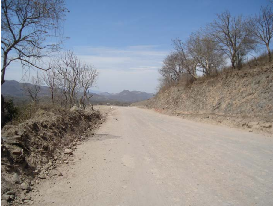
FIGURA 4.29 TERRACERÍA BIEN COMPACTADA Y TERMINADA
