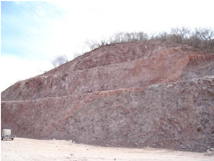
FIGURA 4.30 BERMAS BIEN FORMADAS Y ESTABILIZADAS
