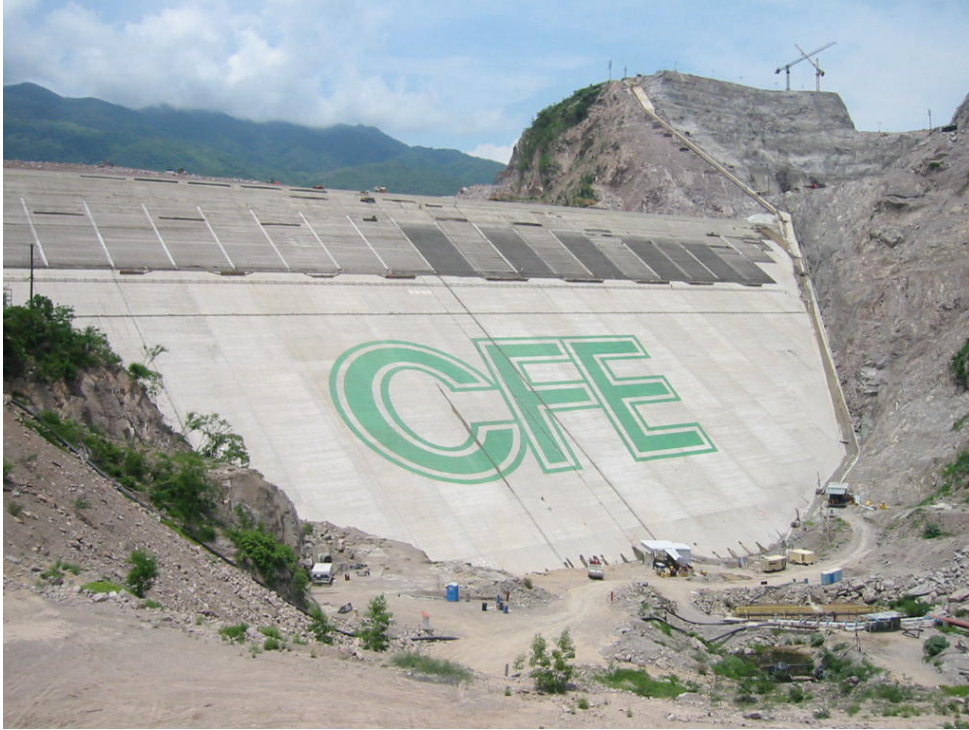
FIGURA 2.7 OBRA DE CONTENCIÓN CON CARA DE CONCRETO
