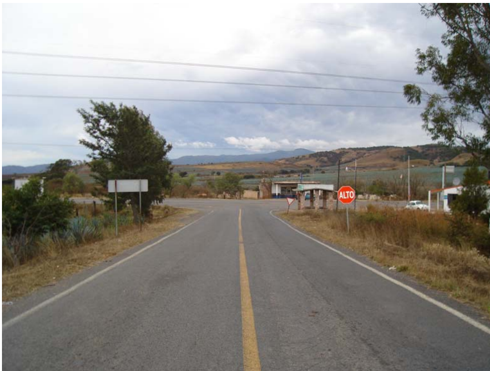
FIGURA 3.5 ENTRONQUE DE LA CARRETERA FEDERAL 15 CON LA CARRETERA A HOSTOTIPAQUILLO. "EL TEQUESQUITE"
