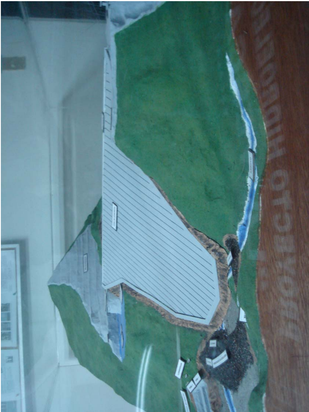
FIGURA 2.2I CARA DE CONCRETO DE LA CORTINA Y ATAGUIAS AGUAS ARRIBA. VISTA DESDE LA MARGEN DERECHA
