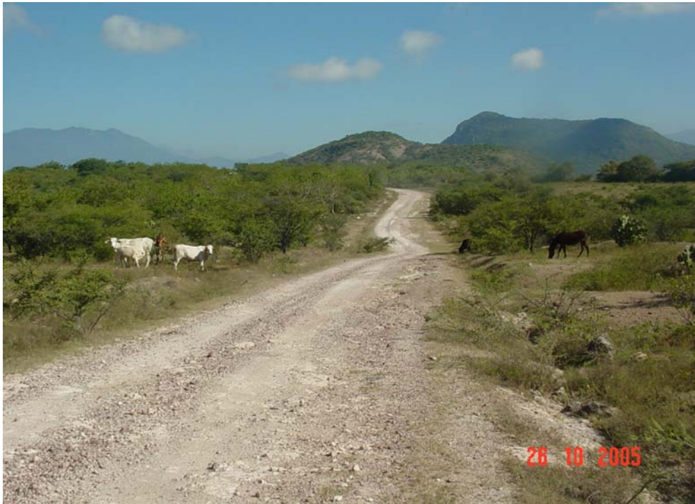
FIGURA 3.10 ESTADO ACTUAL DEL CAMINO DE ACCESO. TRAMO DE UN SOLO CARRIL
