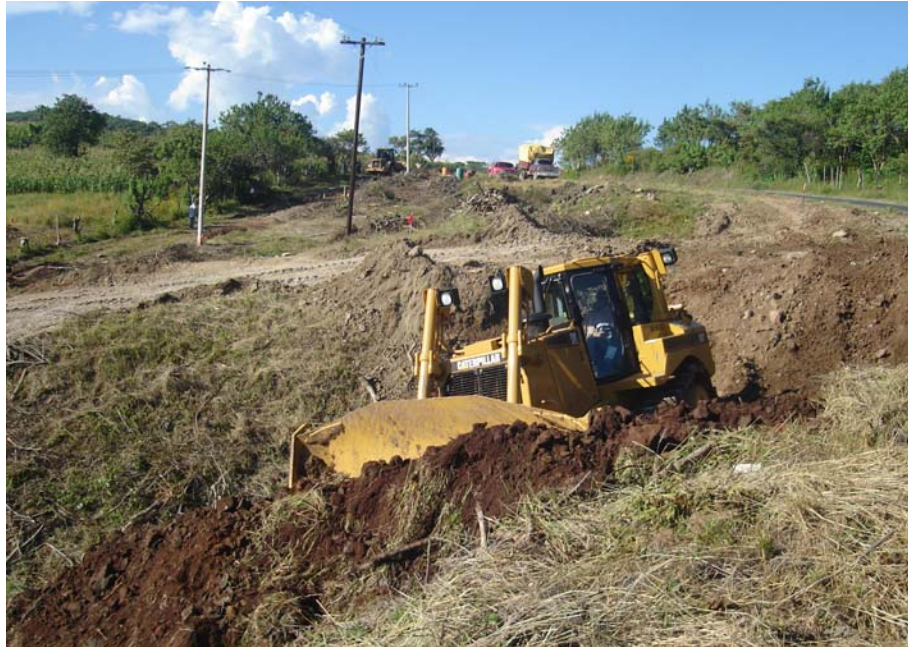
FIGURA 4.9 ADEMÁS DE DESPALME, LOS TRACTORES TAMBIÉN SE USAN PARA LA FORMACIÓN DE LAS TERRACERÍAS TANTO EN CORTES COMO EN TERRAPLENES.
