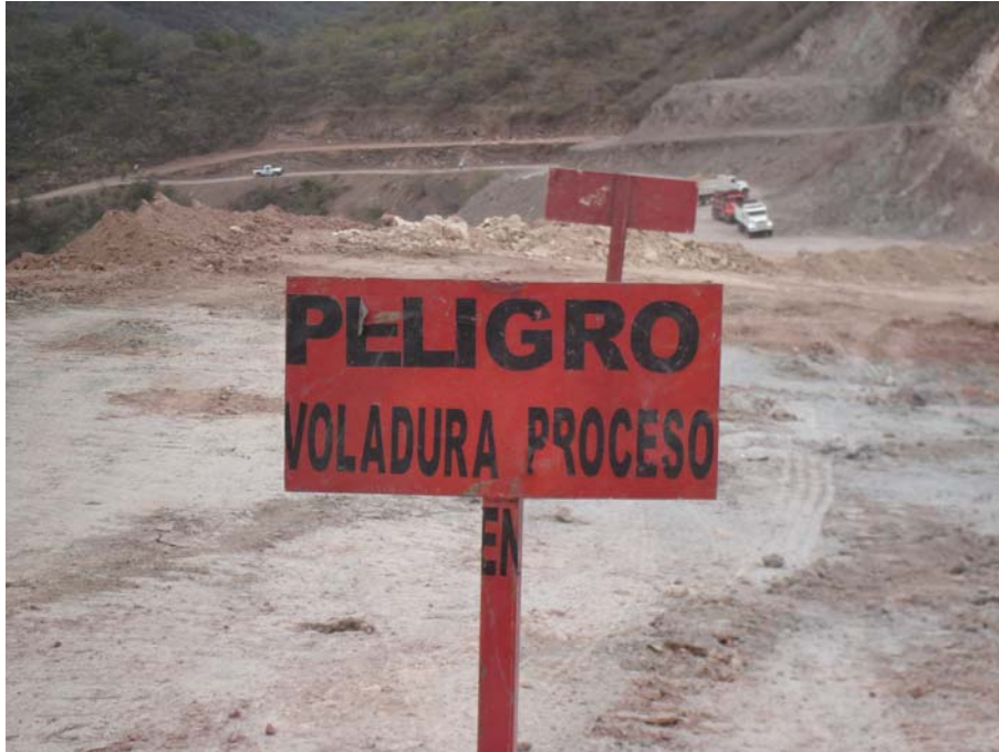
FIGURA 4.16 LA SEGURIDAD DE LOS TRABAJADORES Y DE TODO EL PERSONAL ES PRIMORDIAL POR LO QUE SE COLOCAN ESTOS LETREROS DE "PELIGRO" Y SE HACE SONAR UNA ALARMA DESDE 5 MINUTOS ANTES DE LA VOLADURA PARA ADVERTIR A TODA PERSONA CERCANA QUE SE ALEJE
