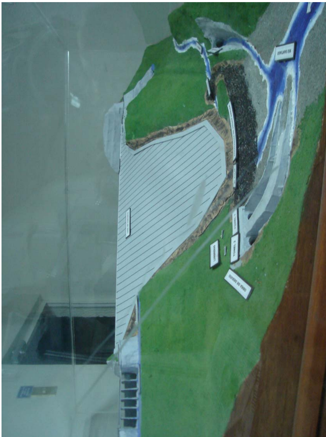
FIGURA 2.22 CARA DE CONCRETO, ATAGUÍAS AGUAS ARRIBA Y TÚNELES DE DESVÍO
