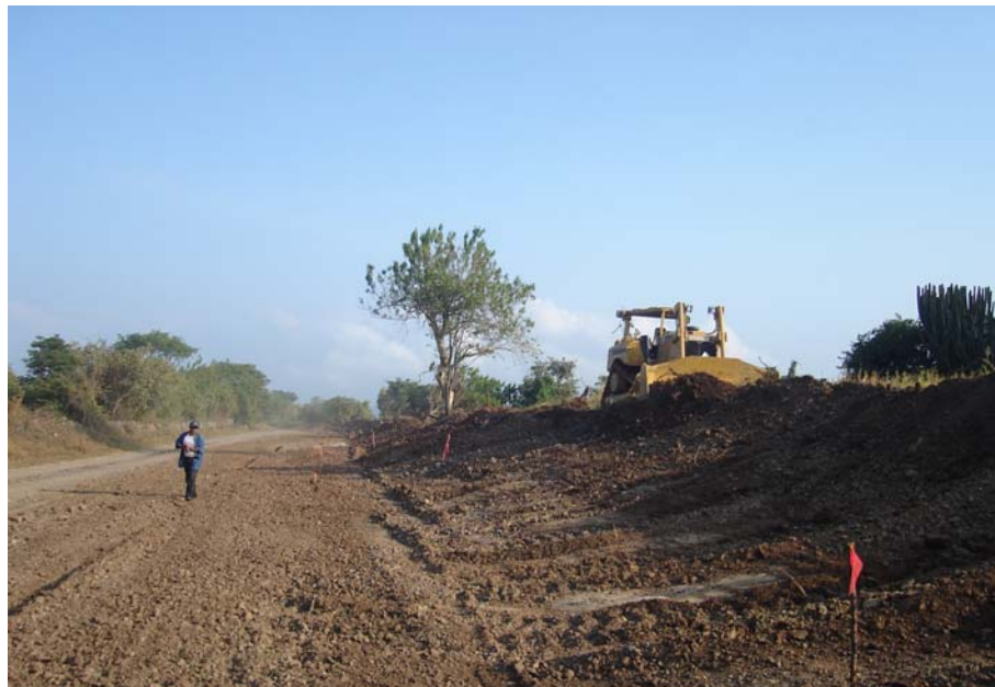
FIGURA 4.10 TAMBIÉN SE USAN LOS TRACTORES PARA LA CONSTRUCCIÓN DE LAS DERIVACIONES DE LA VIALIDAD. ES RECOMENDABLE QUE ÉSTAS SE ENCUENTREN EN BUENAS CONDICIONES DURANTE LA CONSTRUCCIÓN.
