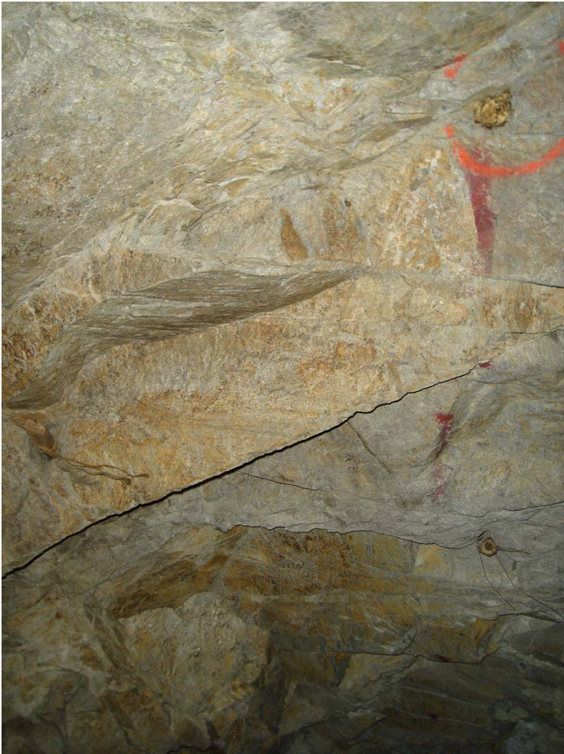
FIGURA 2.20 INTERIOR DEL SOCAVÓN. YA CUENTA CON VARILLAS PARA ESTABILIZAR EL CORTE
