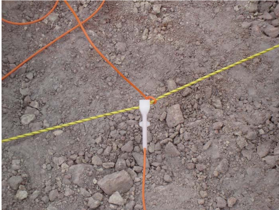
FIGURA 4.14 CADA EXPLOSIVO SE CONECTA A LA LÍNEA PRINCIPAL
