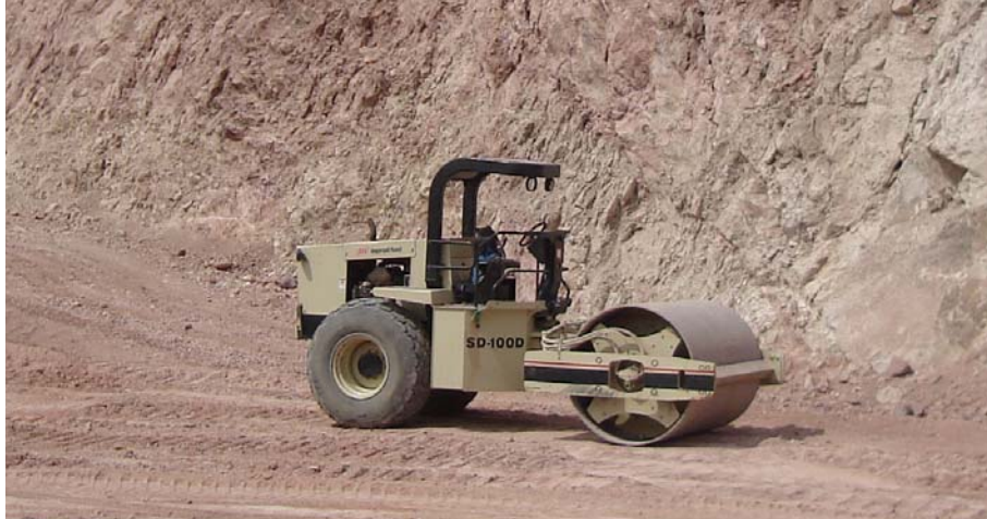
FIGURA 4.11 PARA LA COMPACTACIÓN DE TERRACERÍAS Y TERRAPLENES SE OCUPAN RODILLOS VIBRATORIOS PARA OBTENER LA COMPACTACIÓN REQUERIDA DEL 90% Ó 95%
