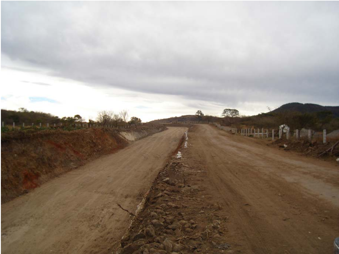
FIGURA 4.8 DURANTE LA CONSTRUCCIÓN DEL CAMINO ES NECESARIO QUE EXISTA UNA VÍA CONSTANTE DE PASO TANTO PARA EL CONTRATISTA, LA CFE Y TERCEROS.
