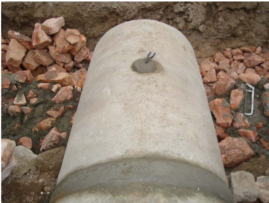
FIGURA 4.25 TUBO DE CONCRETO APOYADO SOBRE MURO DE MAMPOSTERÍA
