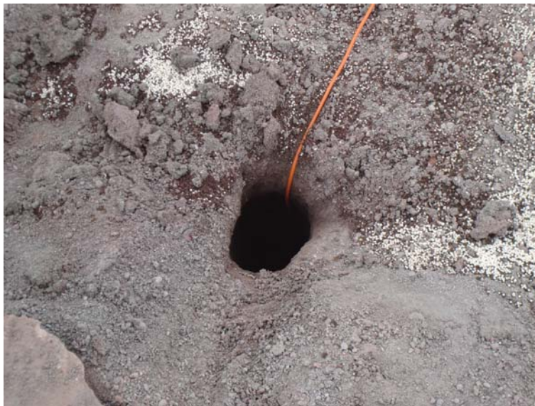
FIGURA 4.13 COLOCACIÓN SE LOS EXPLOSIVOS EN SUS RESPECTIVOS BARRENOS CONECTADOS A LA LÍNEA DE EXPLOSIÓN.
