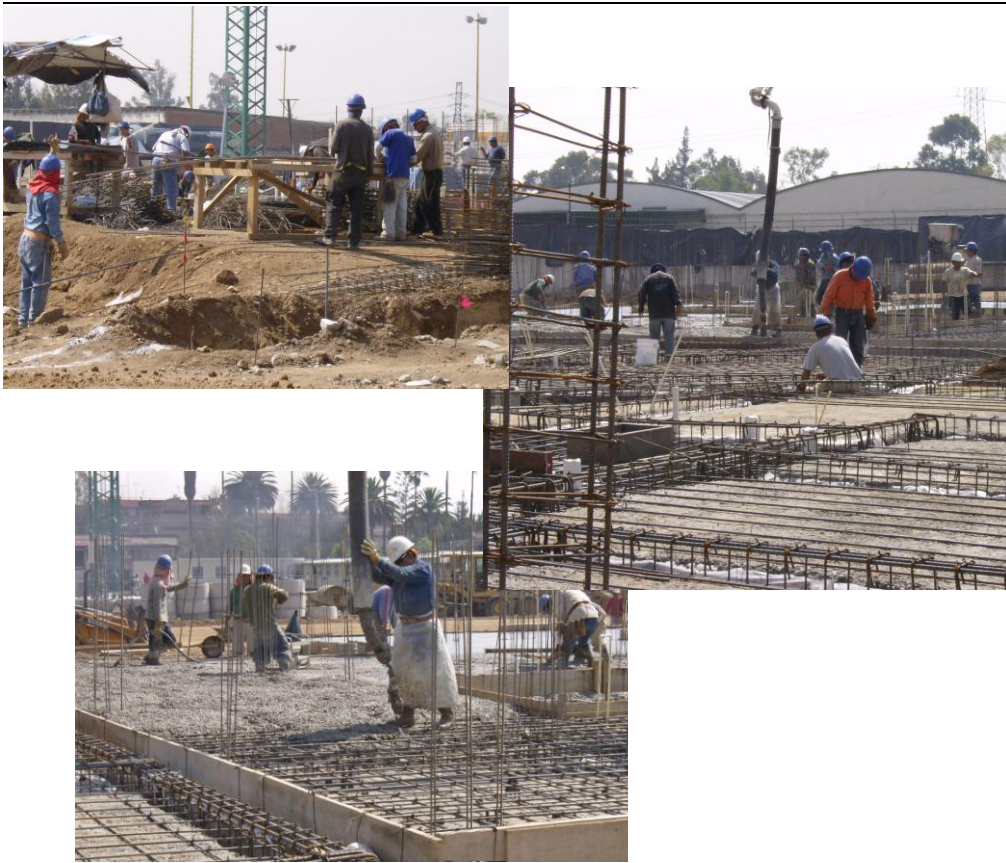
Imagen 17. Colado de la losa de cimentación.
