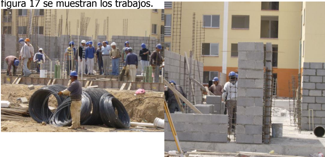
Figura 17. Levantamiento de muros
