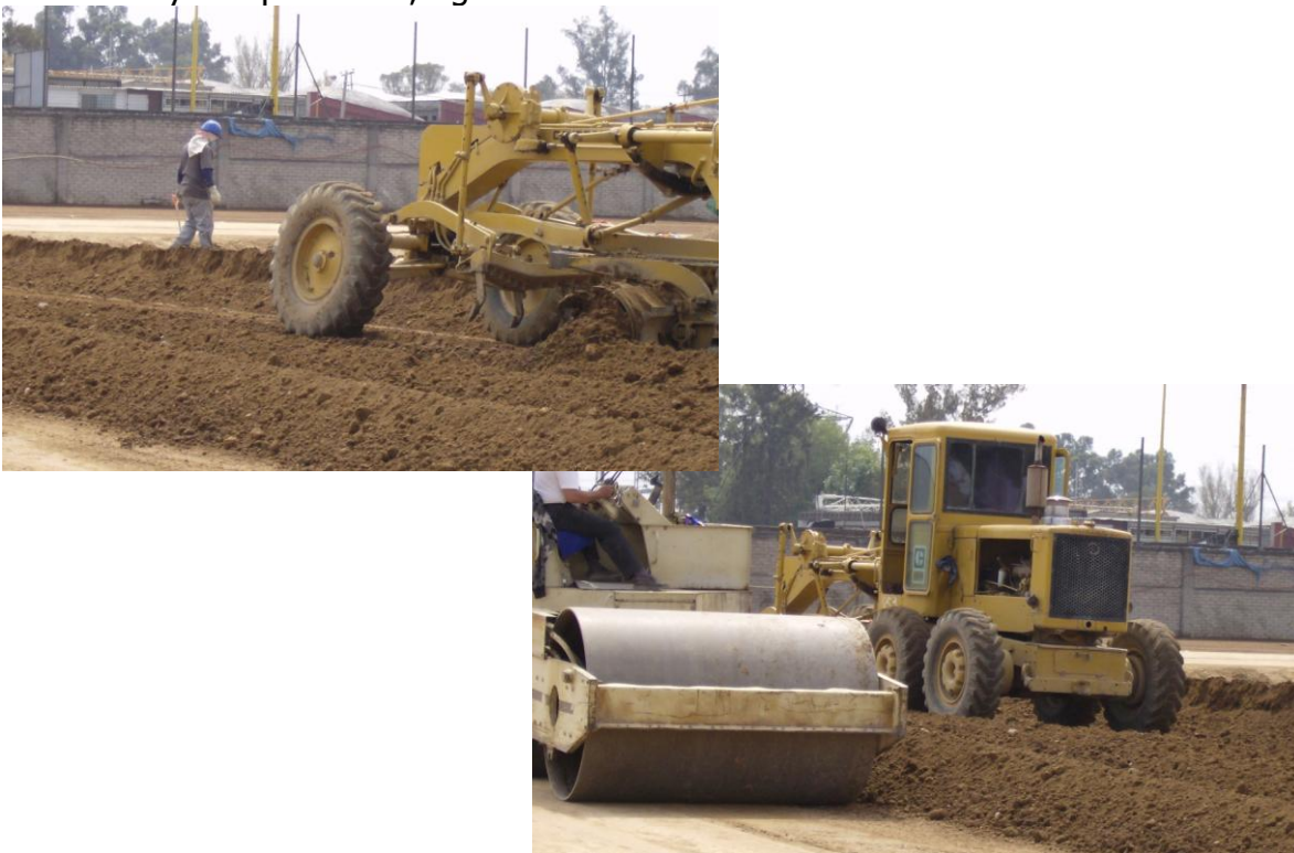
Figura 13. Construcción de terraplén
