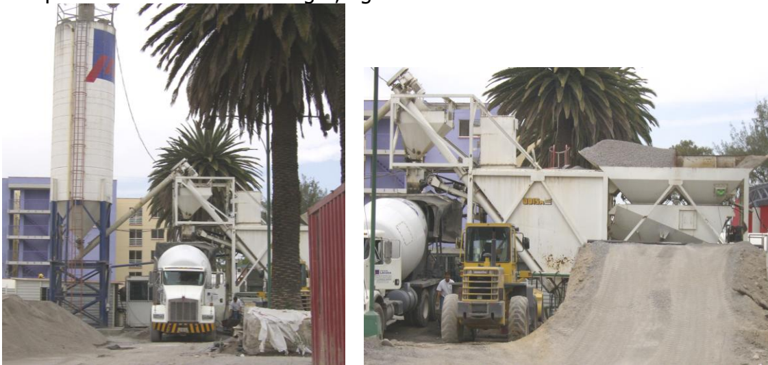
Figura 3. Planta de concreto en el lugar
