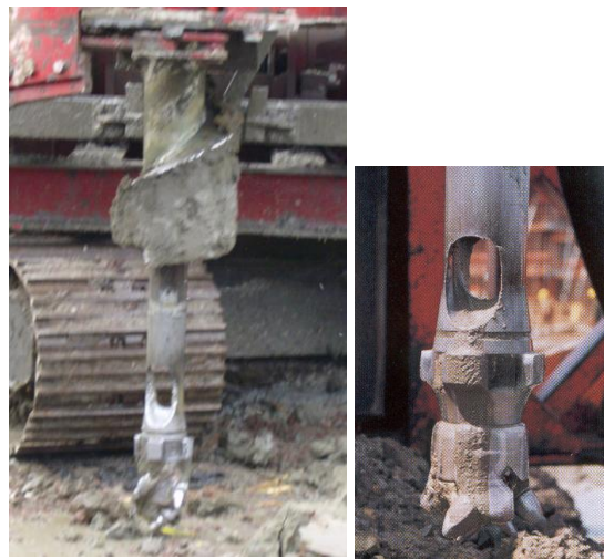
Figura 9. Tubería Tremie y cabeza de perforación
