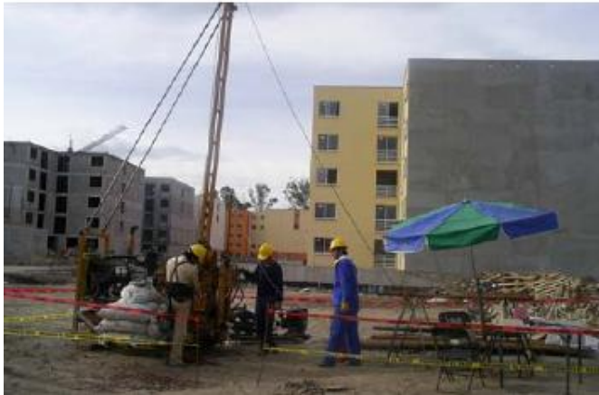
Fotos 6, 7, 8 y 9. Ejecución de los sondeos de cono eléctrico. Se realizaron cinco sondeos, uno en cada vértice del terreno y uno al centro; se realizaron hasta detectar la capa dura, la cual se detectó a una profundidad promedio de 29.2 m.
