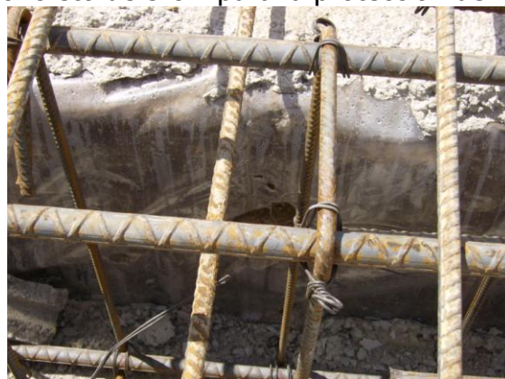
Figura 15. Desplante de cimentación
