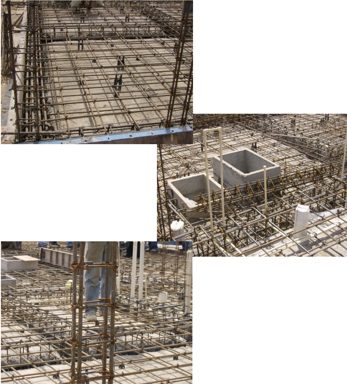
Figura 16. Armado en losas e instalaciones
