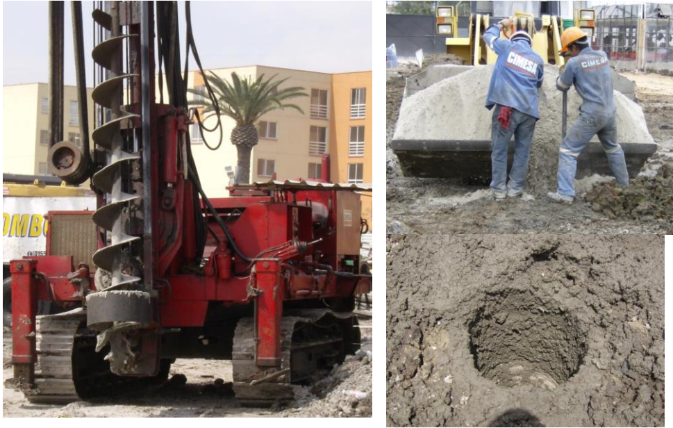
Figura 10. Colocación del material de relleno
