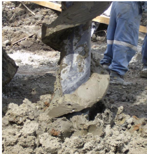
Figura 19. Construcción de pilas con barrena de perforación continua
