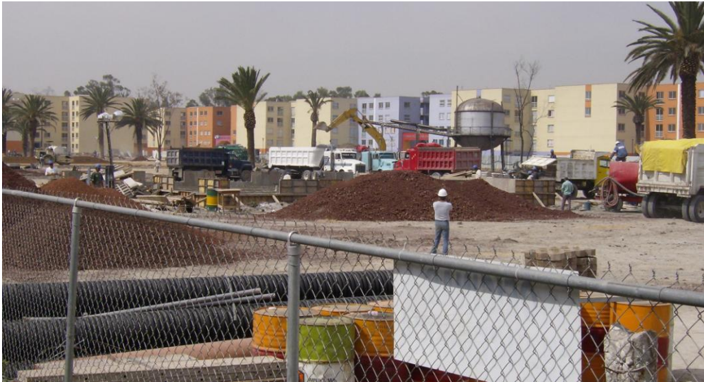
Figura 1. Vista general de obra
