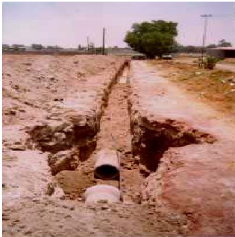
Fotografía 5.4 Relleno con material producto de banco y preparación para pozo de visita.
