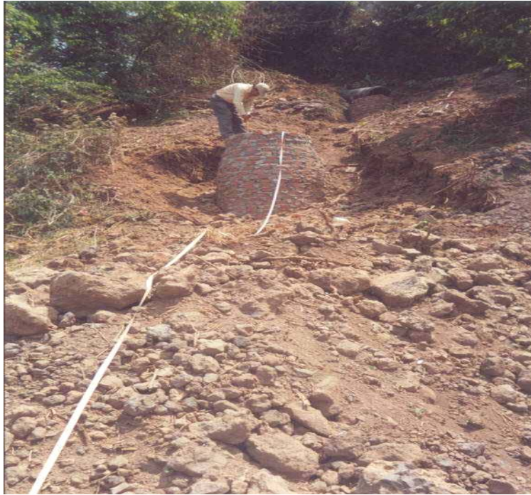
Fotografía.5.1 Alineación y pendiente de pozo de visita
