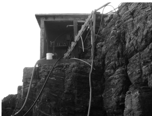
Figura 1.8. Caseta de bombeo
