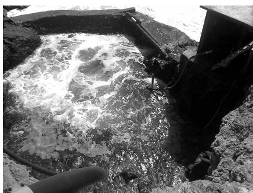
Figura 1.5. Obra de toma de agua salada
