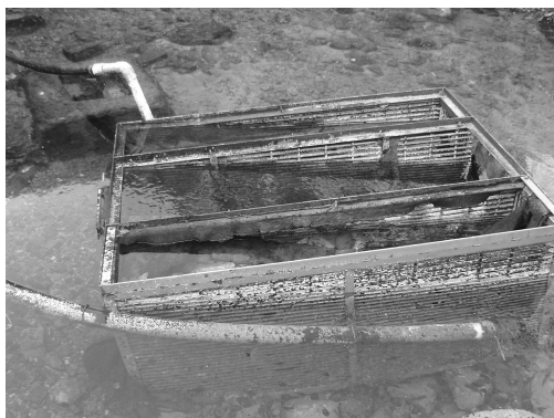
Figura 1.9. Rejilla de protección a la tubería de succión
