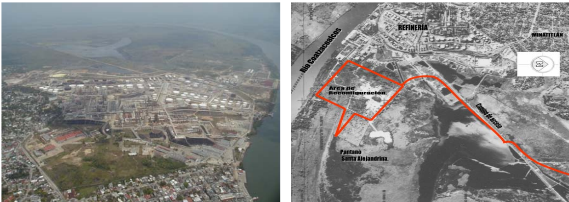
Fig. 5.1 Refinería Lázaro Cárdenas y localización del proyecto.
