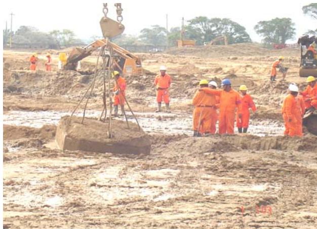
Fig. 5,26 Brigada de campo para los trabajos de compactación dinámica.
