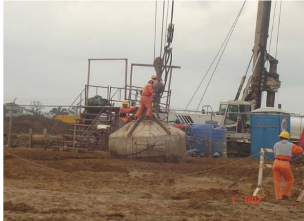
Fig. 4.3 Masa de concreto empleada para compactar el subsuelo
