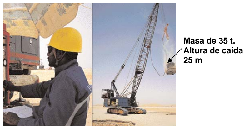
Fig. 4.12 Aplicación de la técnica.
