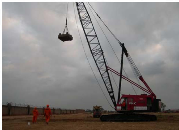
Fig. 5.7 Trabajos de prueba en la plataforma realizada.
