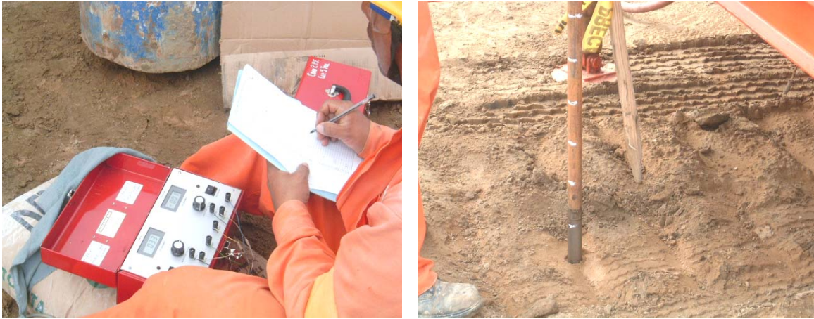
Fig. 5.24 Sondeo de cono eléctrico posterior a los trabajos de compactación dinámica.
