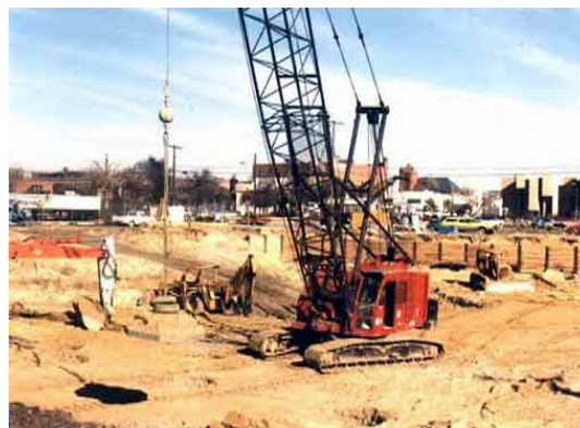
Fig. 4.7 Trabajos de compactación dinámica cerca de estructuras
