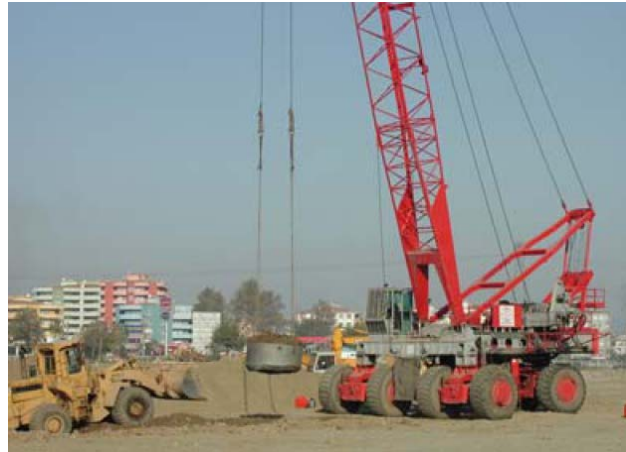
Figura 4.1 Compactación dinámica.
