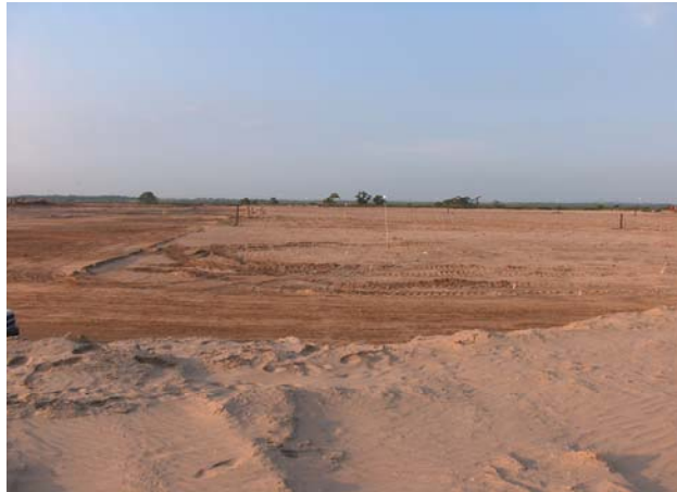
Fig. 1.5 Terraplenes de carga.
