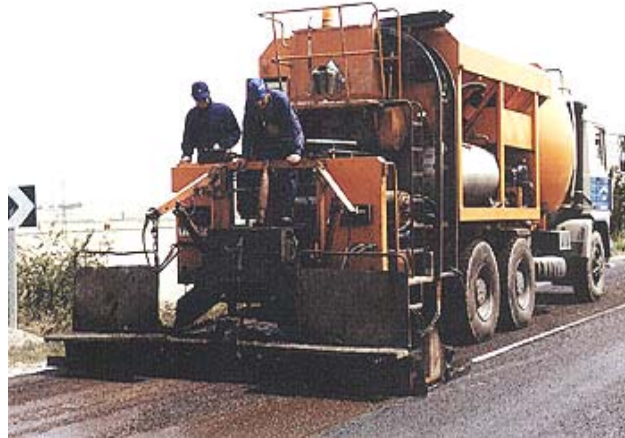
Fig. 1.4 Estabilización del suelo con asfalto.
