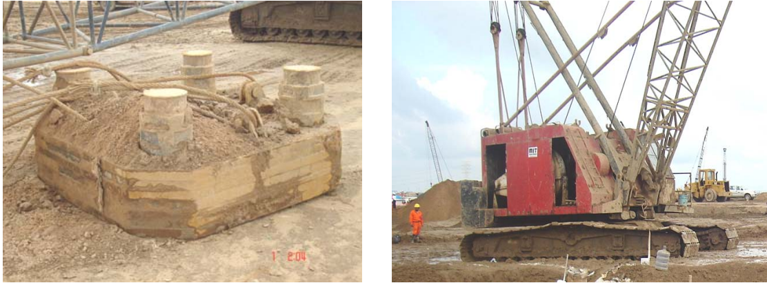
Fig. 5,19 Placa de acero y grúa utilizada para los trabajos de compactación dinámica.
