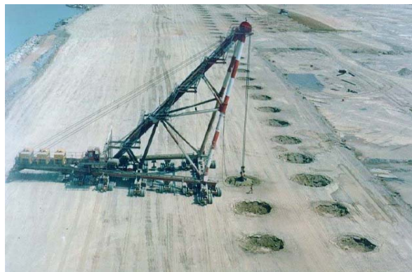
Fig. 2.1 Trípode utilizado para Compactación dinámica.
