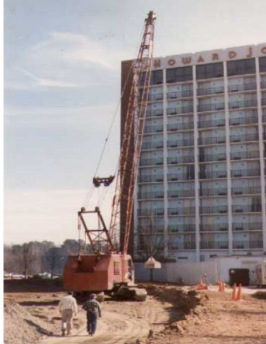
Fig. 4.10 Mejoramiento en la vía de acceso al hotel.
