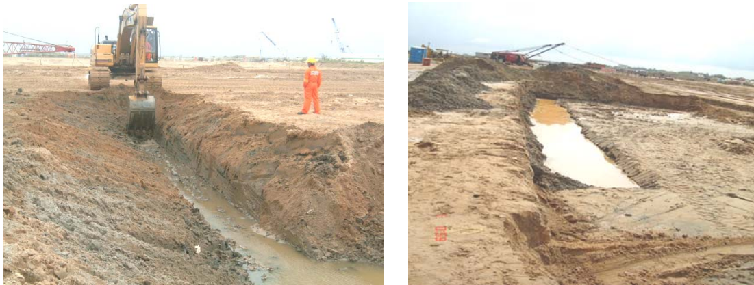
Fig. 5,20 Excavación de zanja para conducir el agua.
