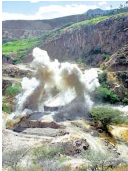
Fig. 1.7 Uso de explosivos
