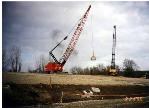
Fig. 4.11 Masa de 15 T y altura de caída de 18 m.
