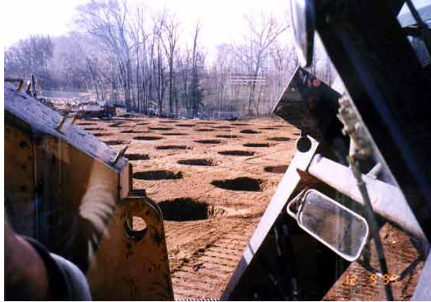
Fig. 4.16 Primera fase de los trabajos en el relleno.
