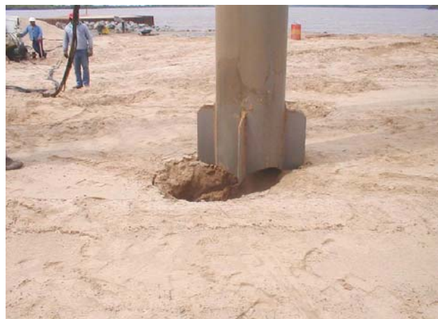
Fig. 1.9 Equipo para trabajos de vibrocompactación.
