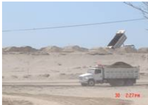
Fig. 5.4 Colocación de los terraplenes de precarga.
