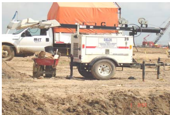
Fig. 5,21 Equipo de iluminación utilizado en la jornada vespertina.
