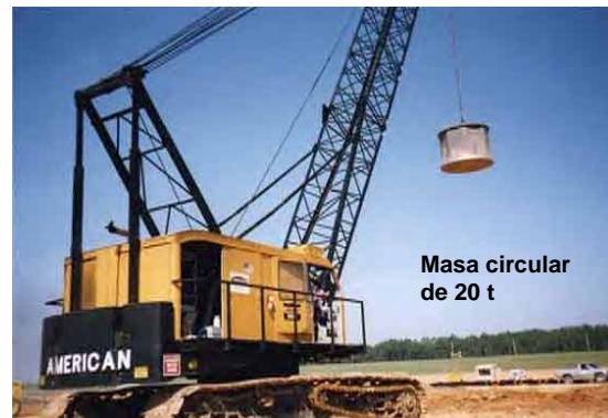
Fig. 4.5 Trabajos realizados en terraplén dragado del río.
