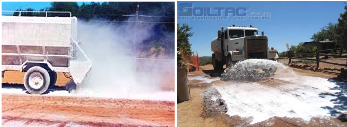
Fig. 1.2 a) Mezcla con cal a granel
