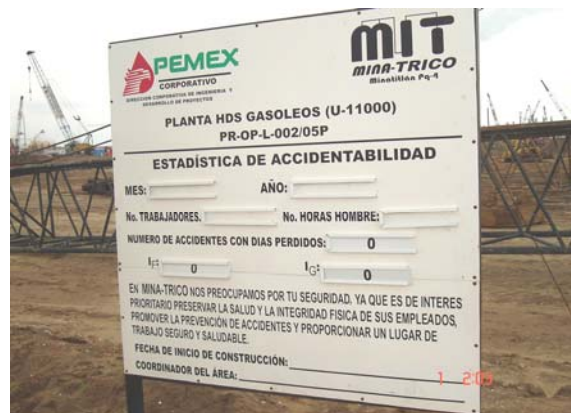
Fig. 5,25 Señalamientos de seguridad en el área de trabajo.
