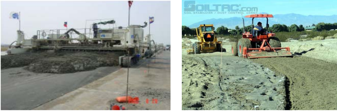
Fig. 1.3 Aplicación del suelo-cemento con escarificador
