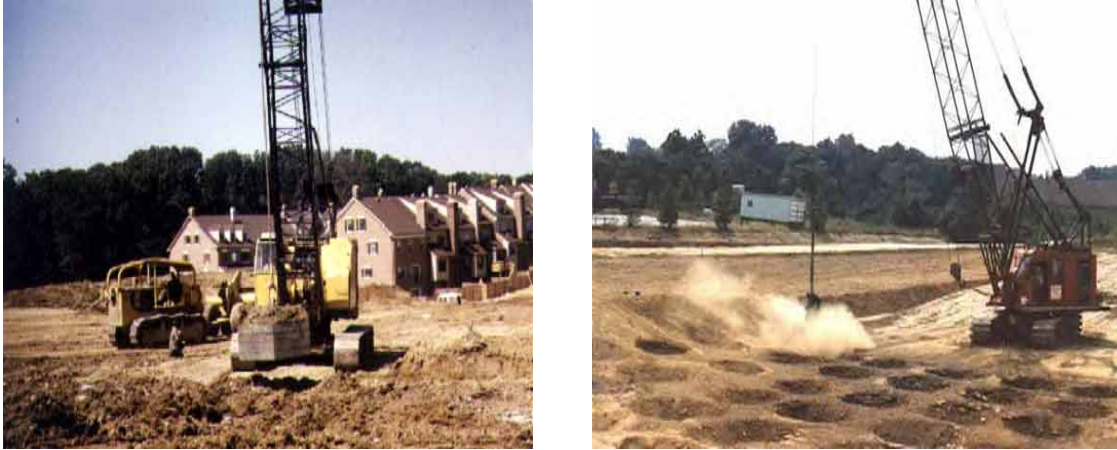
Fig. 4.9 Compactación dinámica en depósitos de escombros.
