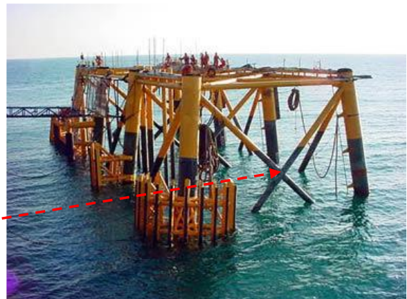
Fig. 3.5. Diagonales de la subestructura en X
