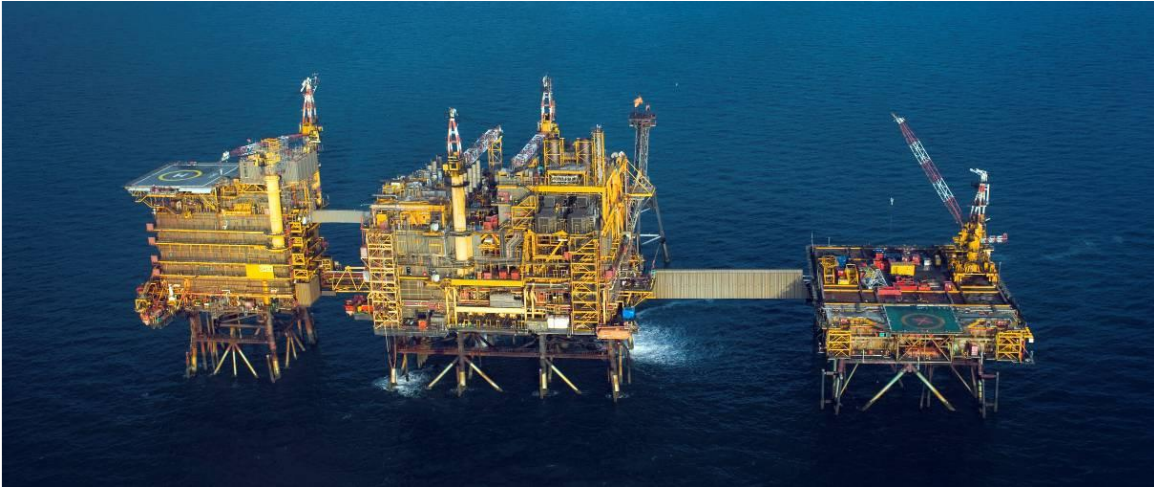
Fig. 2.1. Complejo de plataformas (Producción, Enlace, Compresión y Habitacional).
