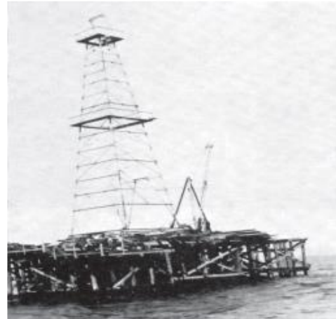
Fig. 1.2. Plataforma construida de madera, Texas, EUA, en 1938.
