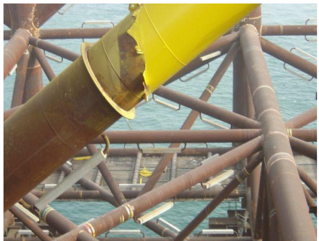
Fig. 3.12. Ejemplo de barras de ánodos de sacrificio en el Jacket de una plataforma.
