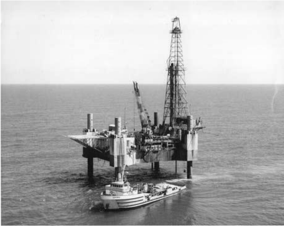
Fig. 1.1. Plataforma tipo Jackup "Vinegaroon" de Petrobras, 1971.
