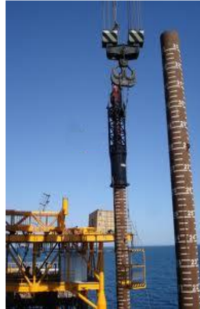
Fig. 4.3. y Fig. 4.4. Fabricación e hincado de pilotes.
