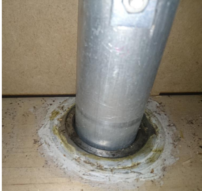
Figura 3.23 Rodamiento inferior del eje principal
