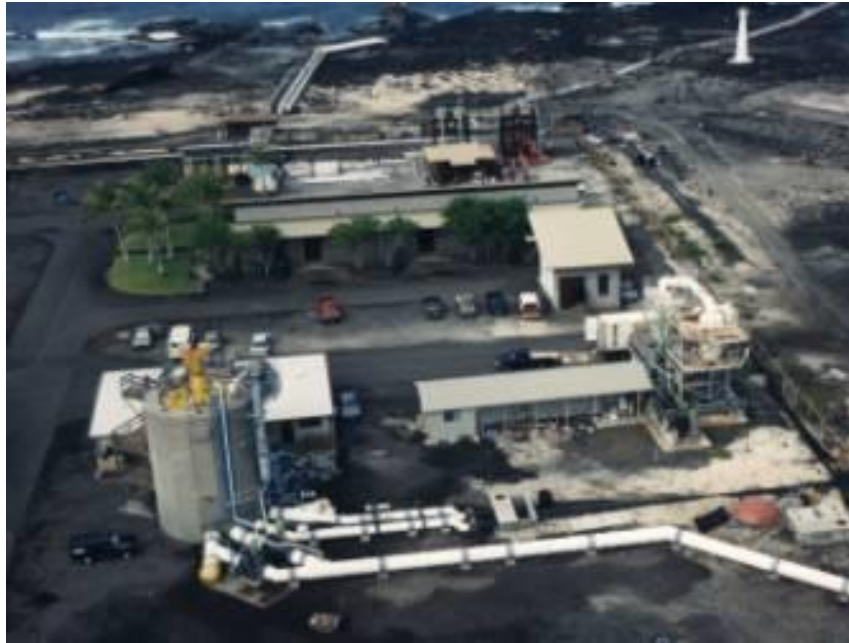
Ilustración 1.10 Planta OC- OTEC de 210 kW, diseñada por el Dr. Barathan (OTEC NELHA, 1998)
