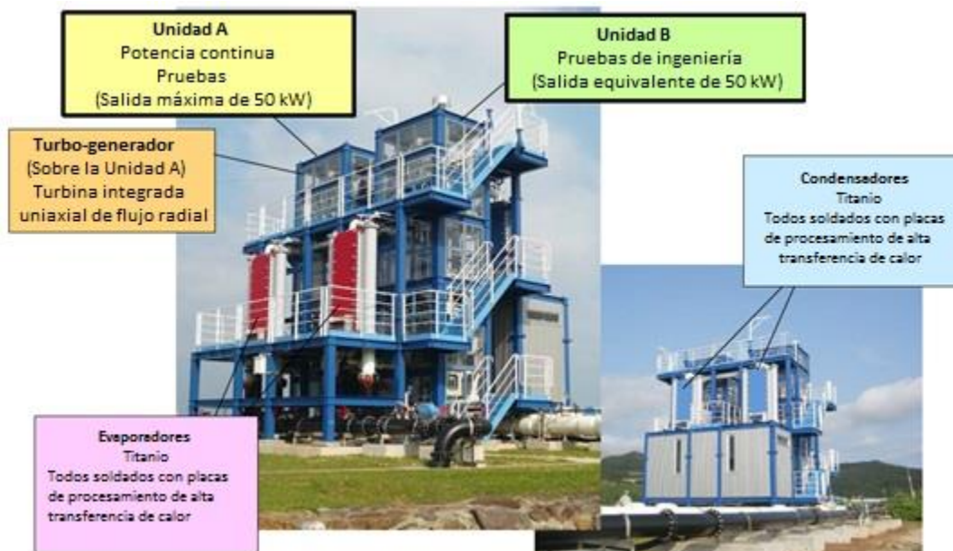
Ilustración 1.11 Planta OTEC Okinawa (OTEC Okinawa, 2013)
