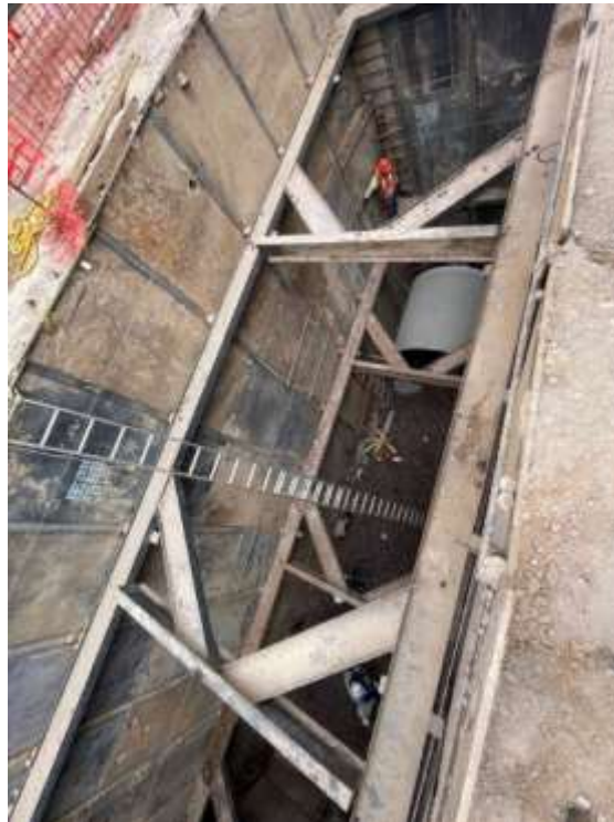
Imagen 24. Trabajos de sistema de contención para la construcción del Colector Río Tacubaya. Imagen propia.
