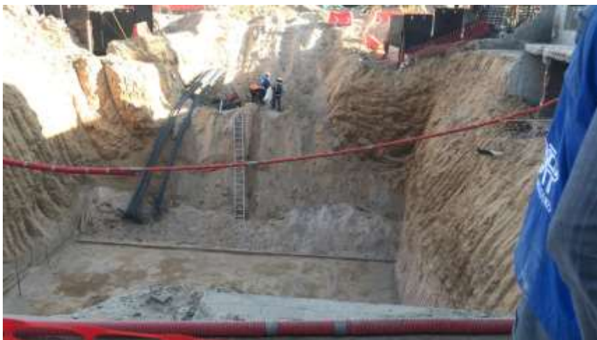
Imagen 9. Trabajos de suministro de acero de refuerzo para pasarela subterránea sur-poniente. Imagen propia.
