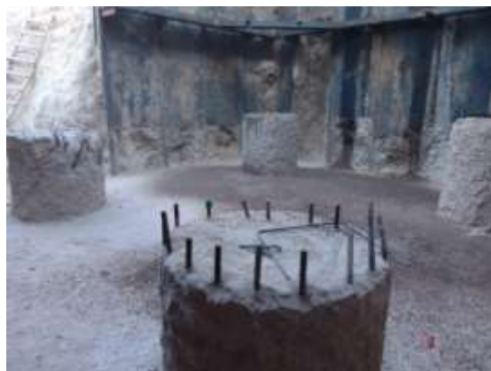
Imagen 20. Trabajos de desplante de plantilla de concreto. Imagen propia.
