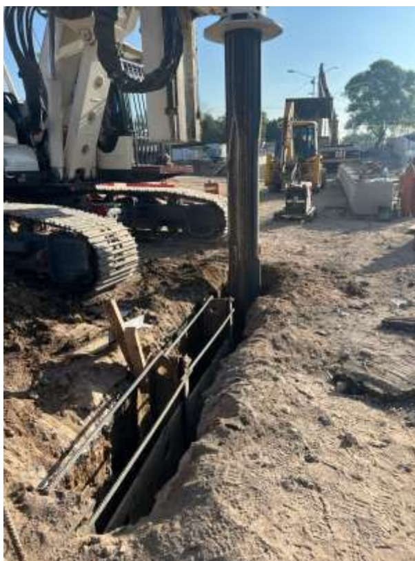
Imagen 23. Trabajos de hincado de vigas IPR. Imagen propia.
