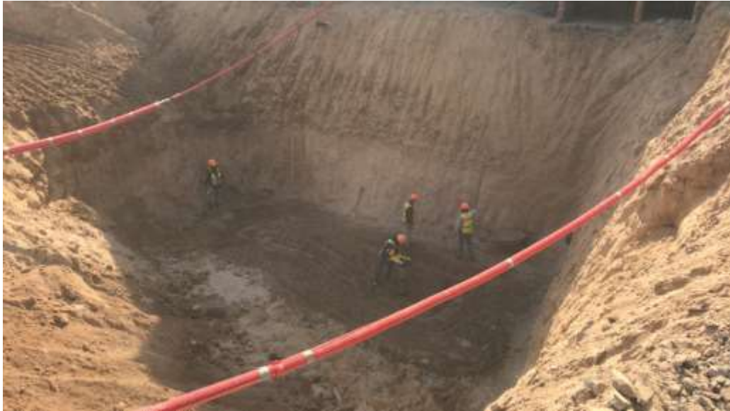
Imagen 7. Trabajos de compactación en pasarela subterránea sur-poniente. Imagen propia.
