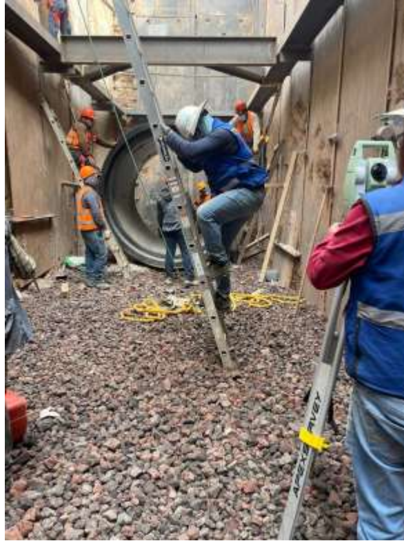
Imagen 25. Trabajos de verificación de ubicación de tubos de concreto reforzado del Colector Río Tacubaya. Imagen propia.
