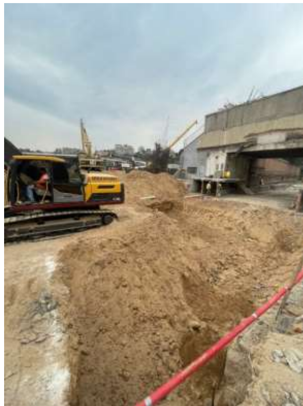
Imagen 3. Trabajos de excavación para la pasarela subterránea sur-poniente. Imagen propia.
