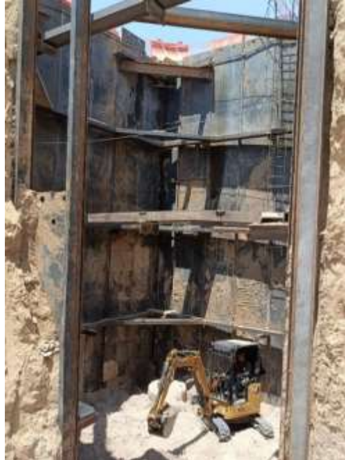
Imagen 19. Trabajos de nivel máximo de excavación. Imagen propia.
