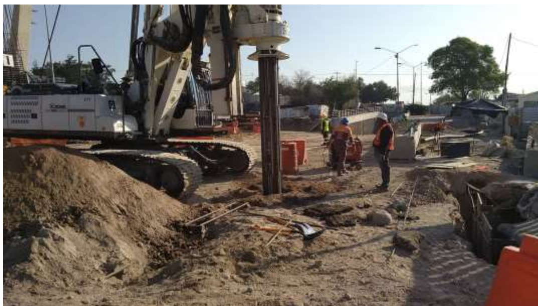
Imagen 22. Trabajos de perforación para hincado de vigas IPR. Imagen propia.
