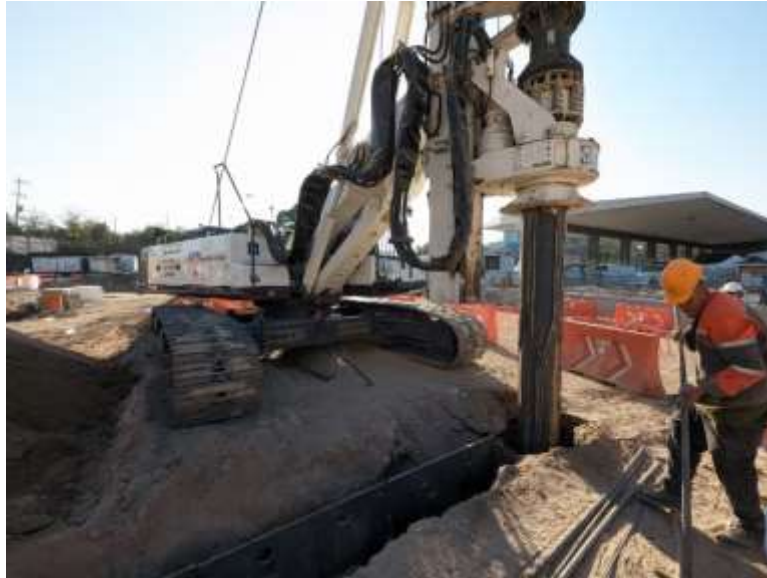
Imagen 17. Trabajos de hincado de placas de acero. Imagen propia.
