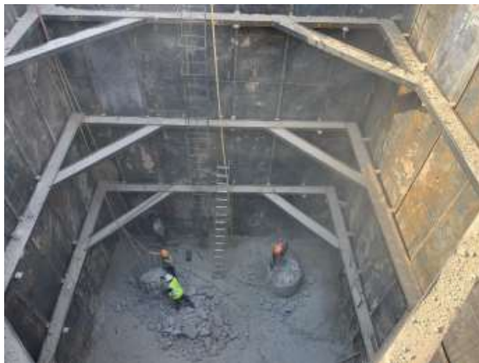
Imagen 21. Trabajos de demolición de pilas de concreto. Imagen propia.
