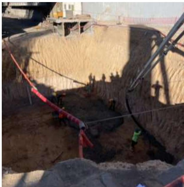
Imagen 8. Trabajos de tendido de plantilla de concreto simple. Imagen propia.
