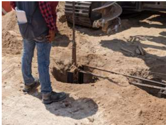
Imagen 16. Trabajos de hincado de vigas IPR. Imagen propia.
