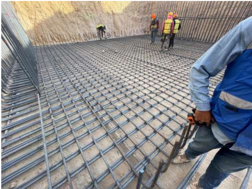
Imagen 13. Trabajos de verificación de colocación de acero de refuerzo para armado de parrilla inferior para losa y muros de pasarela subterránea sur-poniente. Imagen propia.
