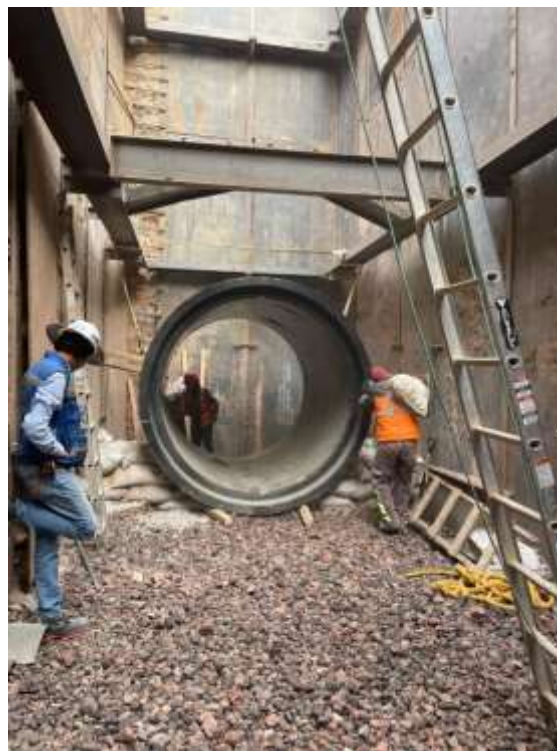
Imagen 26. Trabajos de acostillamiento del Colector Río Tacubaya. Imagen propia.
