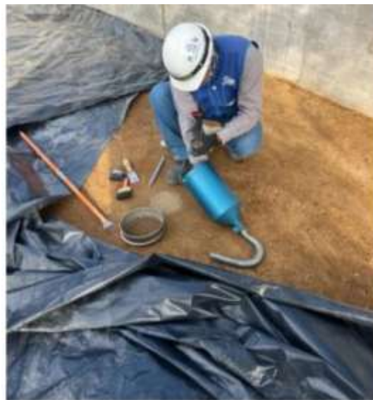
Imagen 6. Trabajos de prueba de compactación. Imagen propia.
