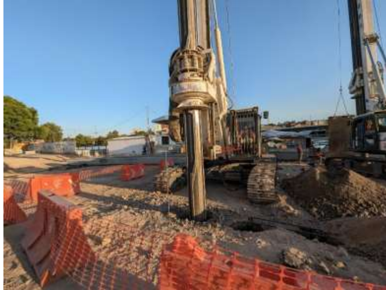
Imagen 15. Trabajos de perforación para hincado de vigas IPR. Imagen propia.
