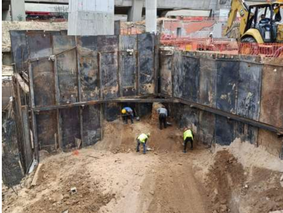
Imagen 18. Trabajos de excavación por etapas. Imagen propia.
