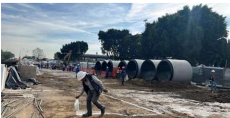
Imagen 1. Trabajos de trazo para pasarela subterránea sur-poniente. Imagen propia.
