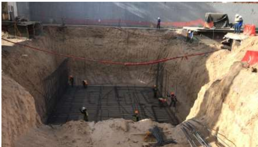
Imagen 11. Trabajos de colocación de acero de refuerzo para armado de parrilla inferior para losa y muros de pasarela subterránea sur-poniente. Imagen propia.
