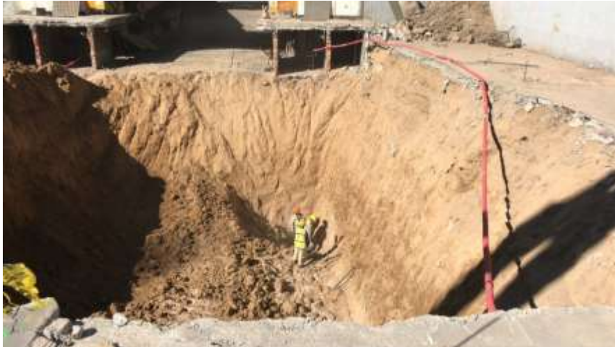
Imagen 5. Trabajos de excavación en pasarla subterránea sur-poniente. Imagen propia.
