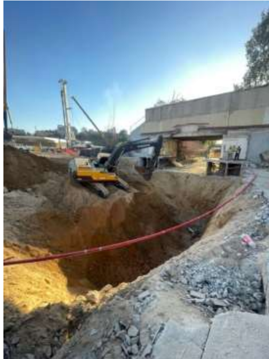
Imagen 4. Trabajos de excavación por etapas para la pasarela subterránea sur-poniente. Imagen propia.
