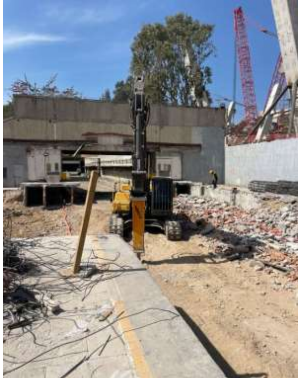
Imagen 2. Trabajos de demolición de andén de ascenso y descenso de pasajeros. Imagen propia.
