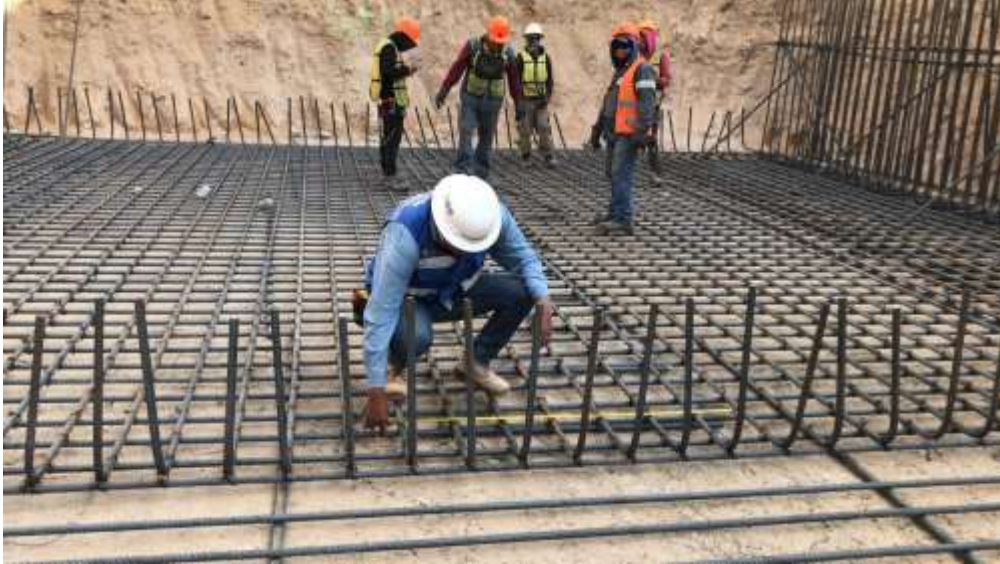
Imagen 12. Trabajos de verificación de colocación de acero de refuerzo para armado de parrilla inferior para losa y muros de pasarela subterránea sur-poniente. Imagen propia.
