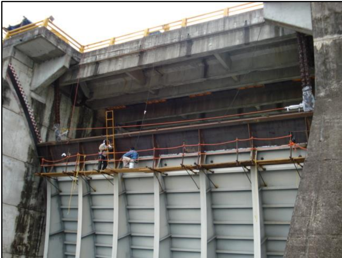
Figura 1.19 Sobreelevación de las compuertas del vertedor de emergencia (CFE, SUBDIRECCION DE GENERACIÓN, 2011)
