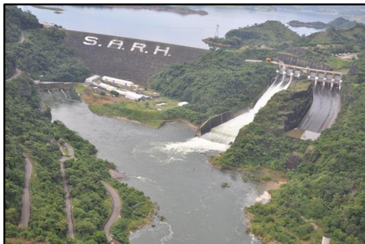
Figura 1.3 Vertedor de servicio en funcionamiento de la C.H. Malpaso
