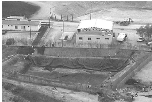
Figura 4.4 Laguna de lixiviados y zona de servicios administrativos
