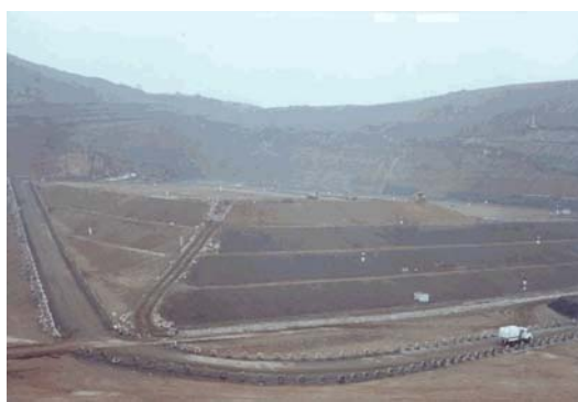
Figura 4.10 Vista de la construcción de acuerdo a proyecto.
