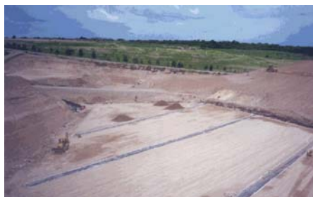
Fig. 5.1 Drenaje de lixiviados
