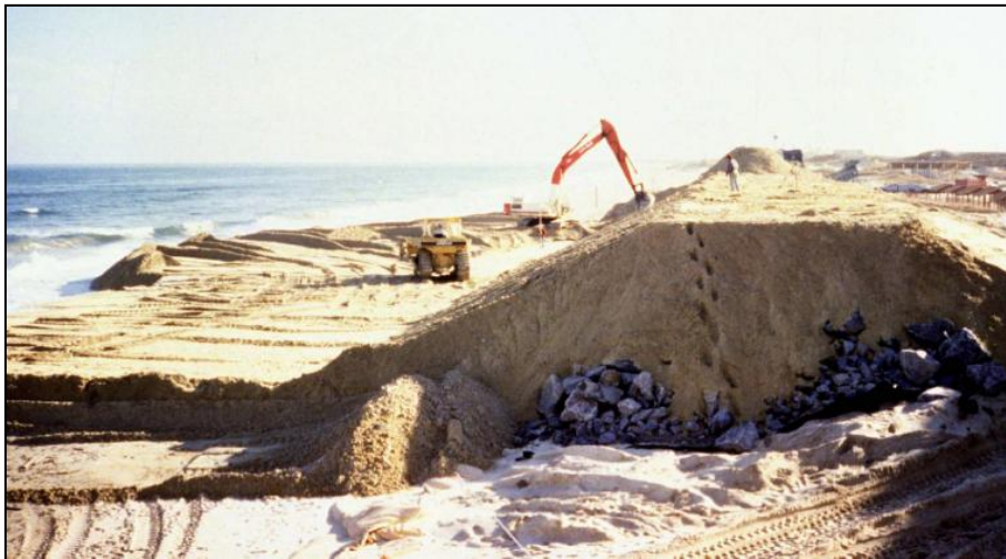
Figura VII.8. Fotografía de la ejecución de la regeneración de la playa de Dam Neck en Virginia, Estados Unidos, (Fuente Basco, 2001, en el capítulo 3, parte V, del libro The Coastal Engineering Manual, publicado por USACE)
