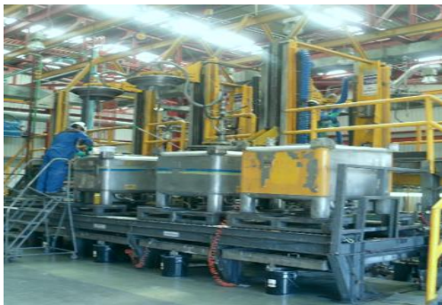
Figura 3.10.1 Línea de lavado 2
