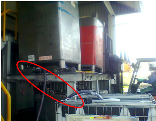
Figura 3.39.1 Conexión del sistema a tierra durante la descarga del prelavado
