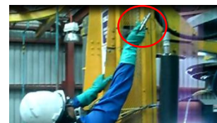
Figura 3.23 Retiro del seguro de la tapa
