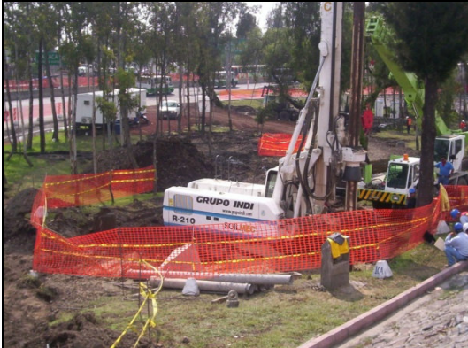
Figura IV.17 Hincado de Pilotes.
