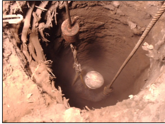
Figura III.9 Inspección Visual a Perforación.
