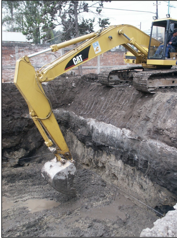
Figura V.14 Proceso de Excavación.
