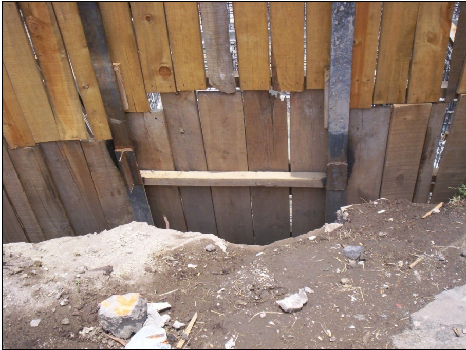
Figura V.9 Muro de contención.
