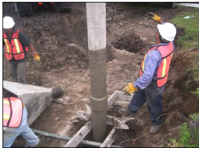
Figura III.16 Colado de la Pila.
