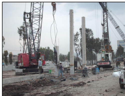
Figura IV.13 Verificación de verticalidad.
