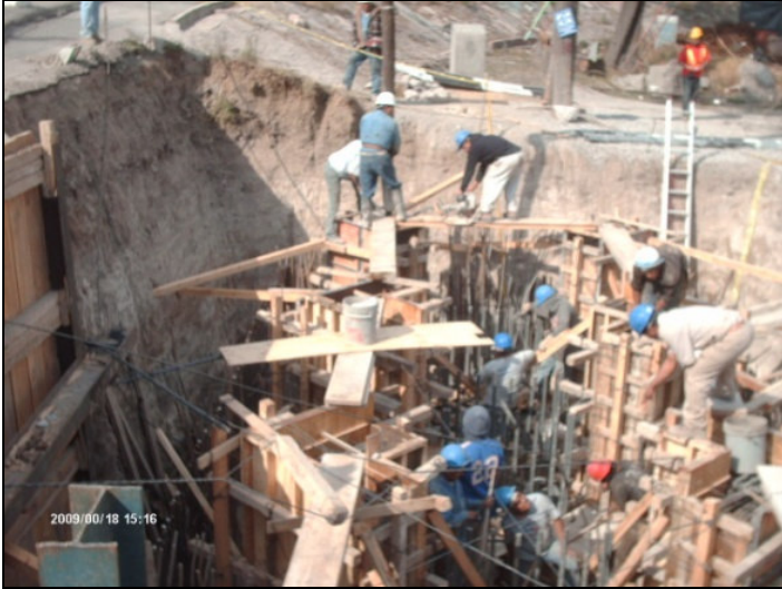
Figura V.19 Cimbrado de contrafuertes.
