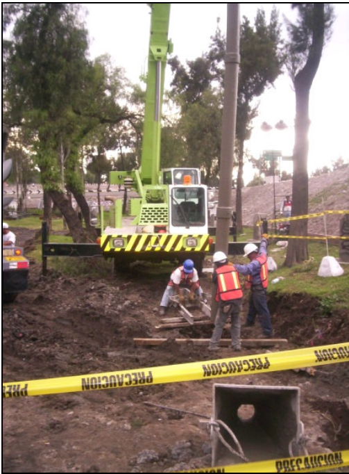
Figura III.15 Colocación del Tubo Tremie.
