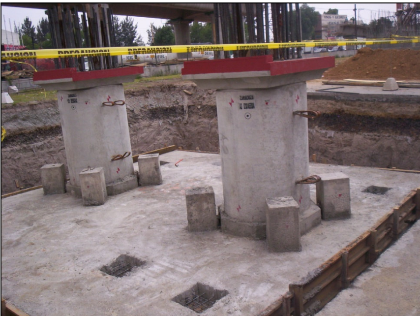
Figura V.28 Unión Final de Cimentación con Superestructura
