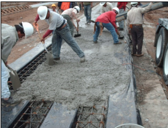
Figura IV.3 Colado de Pilotes.
