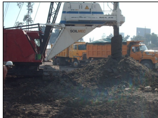
Figura III.5 Proceso de Perforación.
