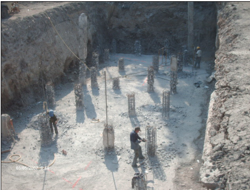
Figura V.16 Descabece de Cimentación Profunda.
