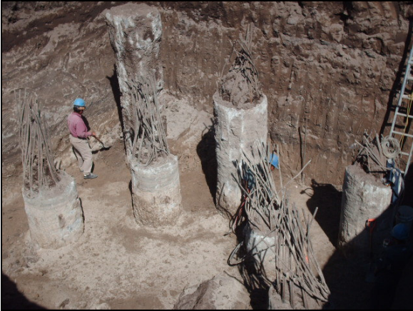
Figura I.6 Pilas coladas en sitio.
