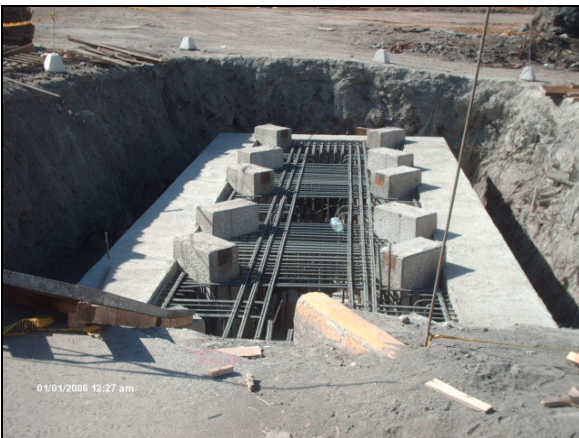
Figura I.8 Zapatas de cimentación.
