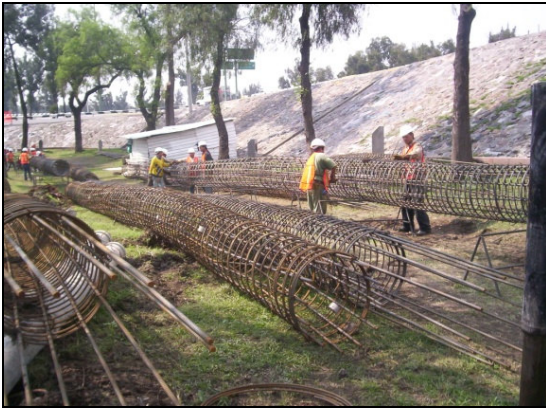
Figura III.8 Acero de Refuerzo de Pilas.
