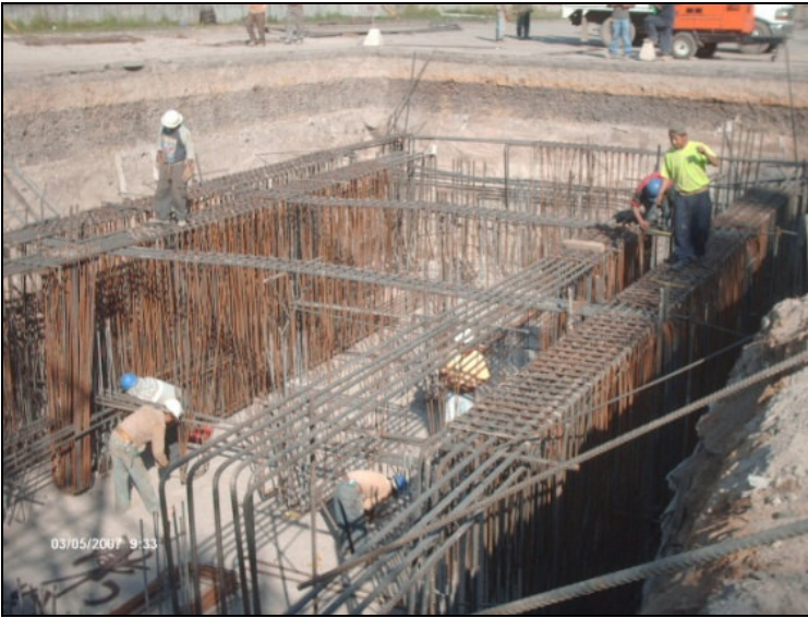
Figura V.21 Armado de contratraves.
