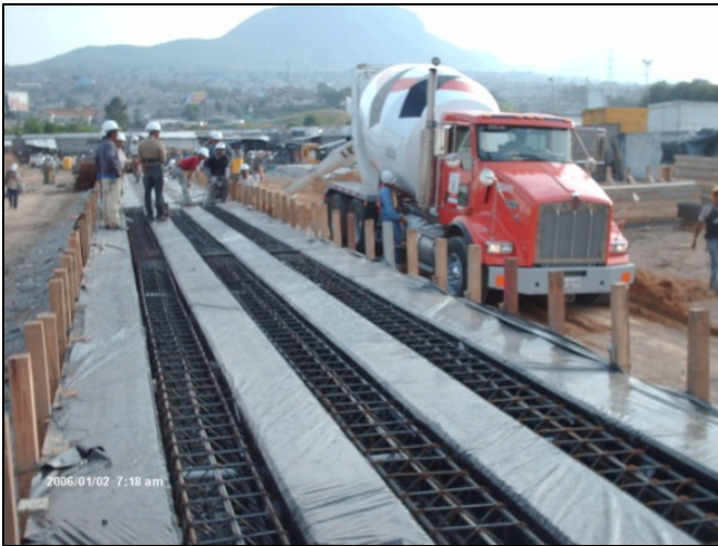
Figura IV.2 Fabricación de Pilotes.
