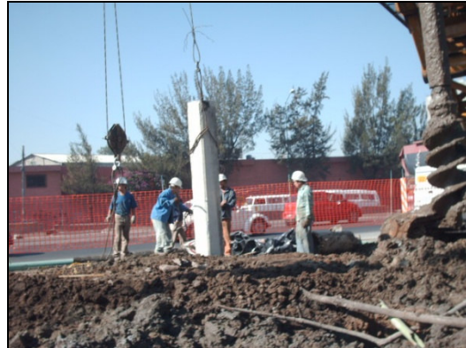
Figura IV.18 Verificación de verticalidad.
