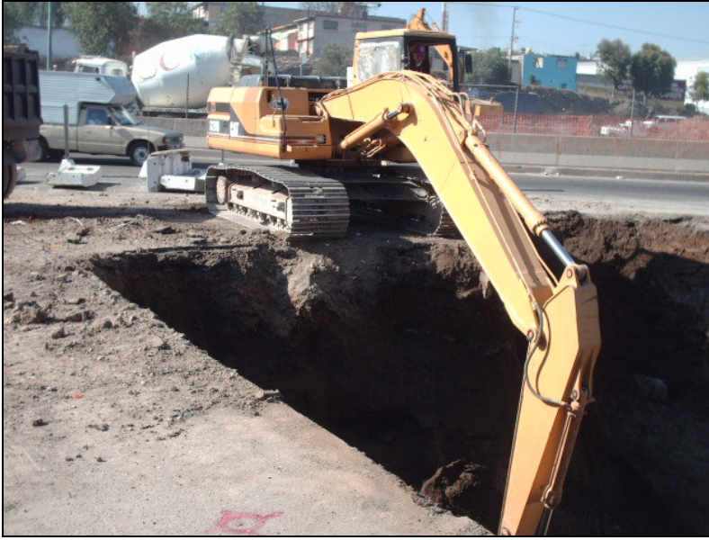
Figura V.17 Proceso de Excavación
