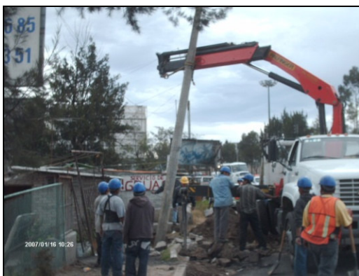
Figura IV.12 Proceso de Izaje.
