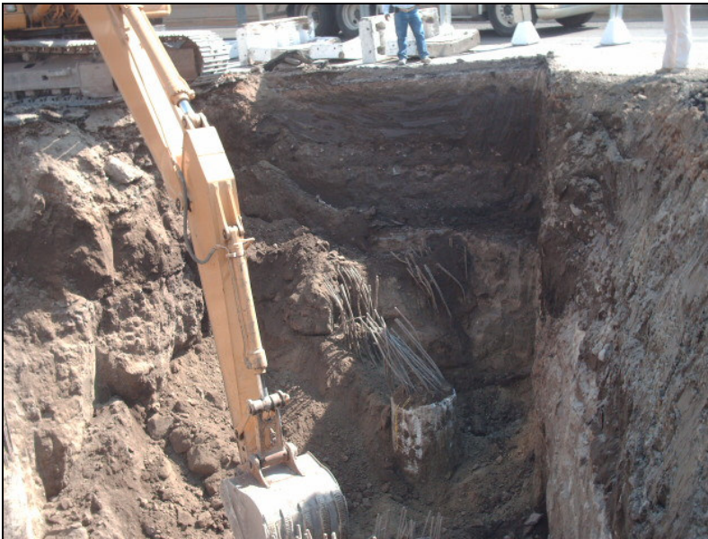
Figura V.18 Proceso de Excavación.
