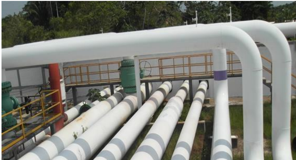
Figura 4.9 Área de cabezales de descarga de los patines de medición.
