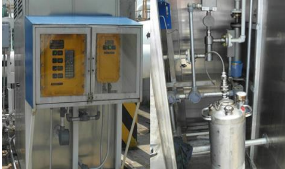
Figura 4.8 Instrumentación en los patines de medición y patines de calidad
