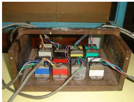
Fig. 2.17 Montaje de acelerómetros sobre base metálica
