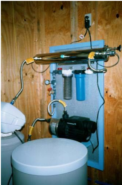
Figura 30 Configuración de tratamiento (sin tanque de presión) de una bomba bajo demanda, filtro de 5 micras, filtro de carbón activado de 3 micras y lámpara ultravioleta
