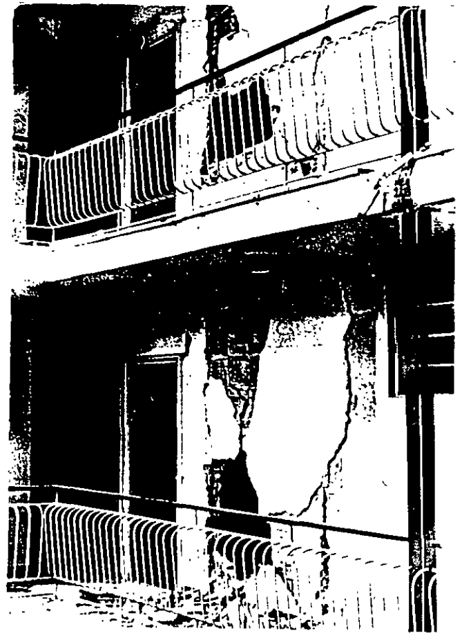
Fig 2 Daños en fachadas "no estructurales"
