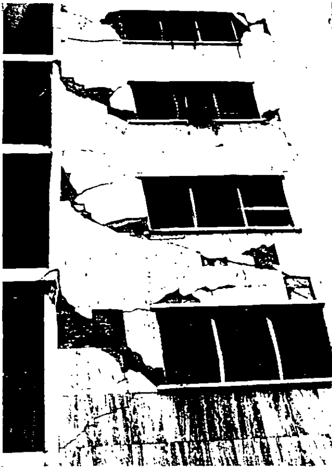
Fig 2 Daños en fachadas "no estructurales"
