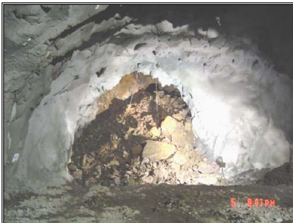
Fotografía 20.- vista del derrumbe en el cadenamiento 0+132,00 del túnel de desfogue, donde las condiciones geológicas provocaron la inestabilidad por la presencia de la falla Crucero-Lagartos.
