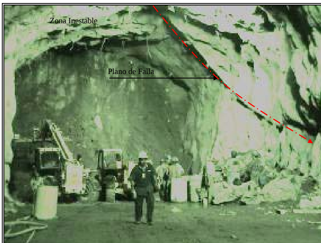
Fotografía 6. Túnel auxiliar de construcción donde se observa el plano de falla en la bóveda orientado a rumbo del túnel provocando la formación de una cuña potencialmente inestable
