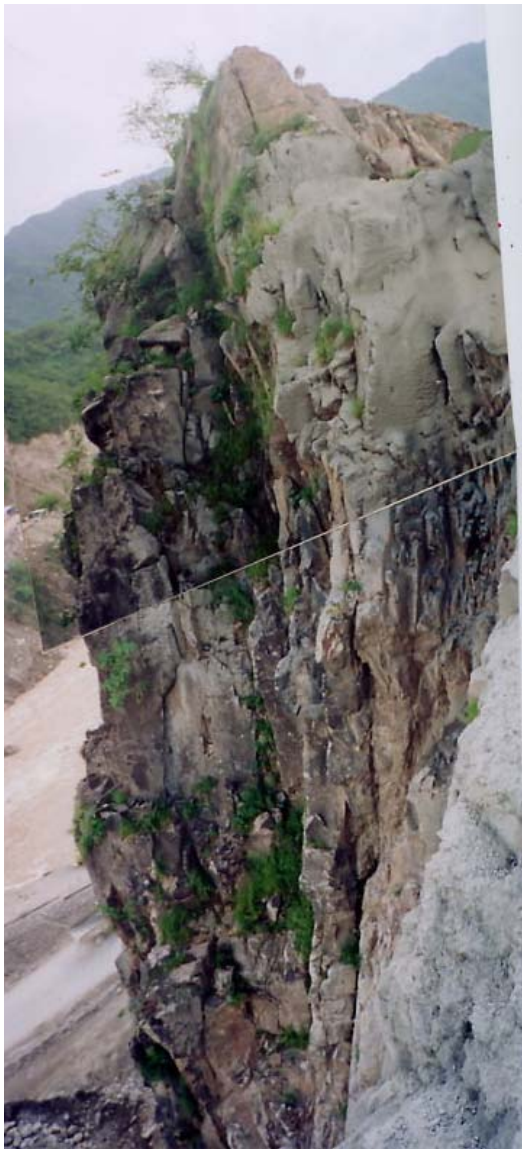
Fotografía 22.- Vista hacia aguas abajo del cantil de la parte superior de la salida del desfogue, donde se aprecia el intenso fracturamiento del macizo rocoso y su fuerte proceso de relajamiento de su borde superior (problema independiente a la estabilidad general del macro bloque).
