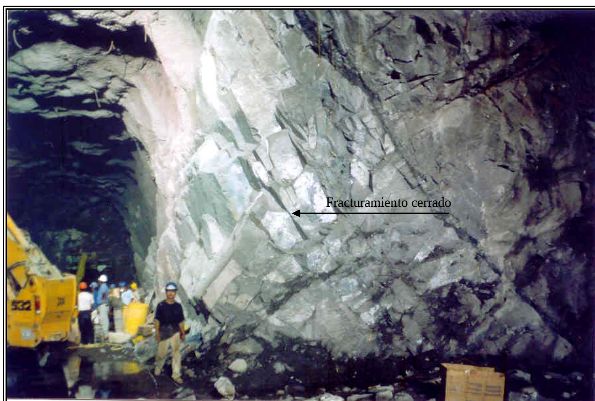
Fotografía 14. Pared de aguas arriba de la casa de máquinas, nótese el fracturamiento cerrado y continuo característico de esta zona
