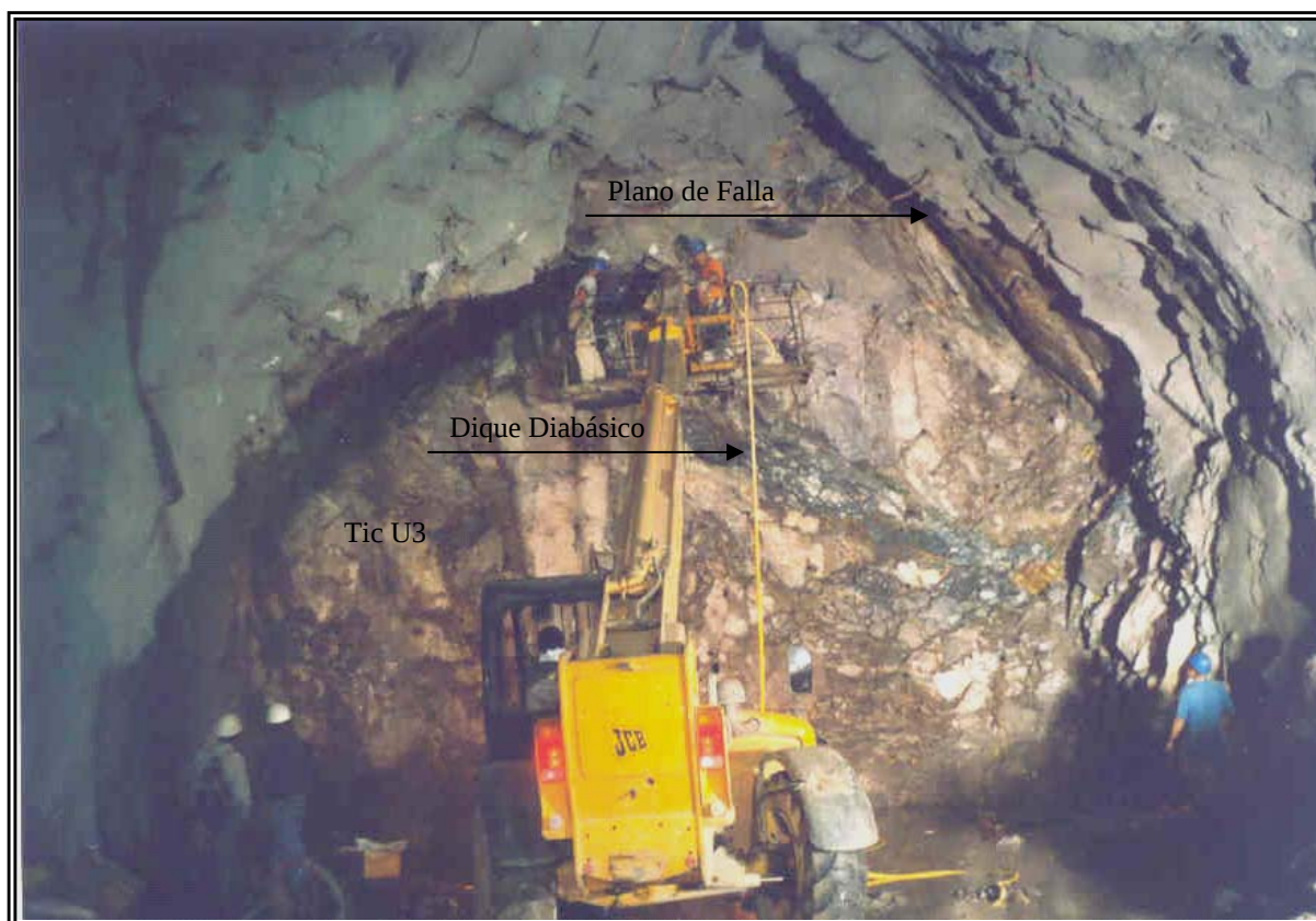
Fotografía 1. Túnel de acceso a casa de máquinas en el cadenamiento 0+191,50, donde se muestra la inestabilidad de la bóveda en forma de cuñas.
