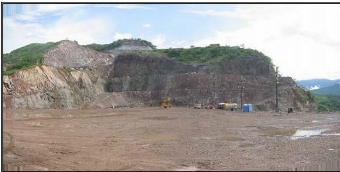
Fotografía 24.- Excavación de la plataforma de la subestación, en el lado izquierdo el talud NW que separa del canal de descarga, en el centro los taludes NE que la separan de la obra de toma.
