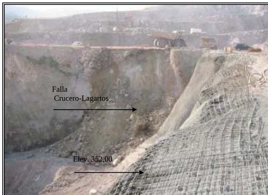
Fotografía 28.- Vista del derrumbe ocurrido en la subestación a la elevación 363,00. Nótase el desprendimiento del material alterado y triturado formado por la convergencia de las fallas Crucero-Lagartos y Fd3 (falla cañada de los diques).
