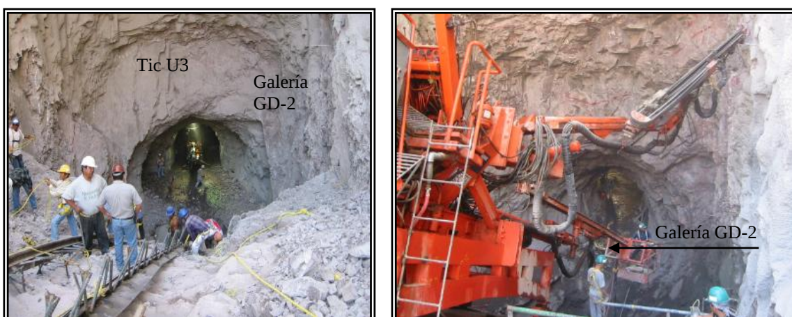
Fotografía 7. Vista de la excavación de las dos tuberías en el codo superior, donde se observan las características de la roca, al fondo en la del lado izquierdo, la galería GD-2
