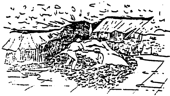
FIGURA 6.11 Cubrimiento de los desechos sólidos
