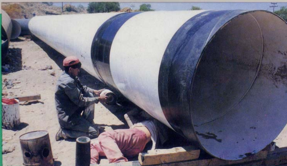
Trabajos de protección anticorrosiva de tubería de a
