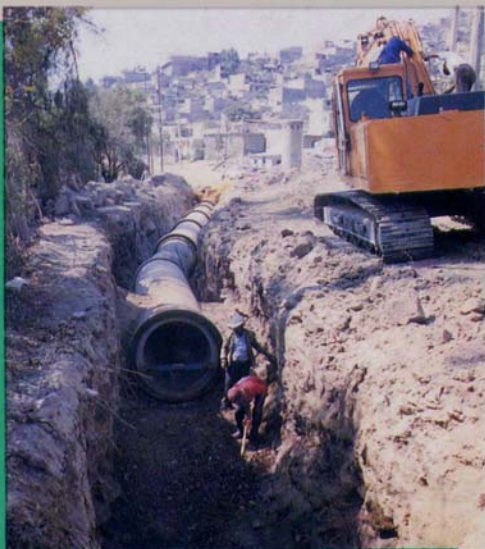
Tendido de tubería de concreto presforzado
