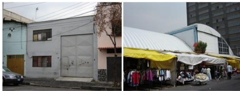
Figura 11.- Sistema de naves industriales
