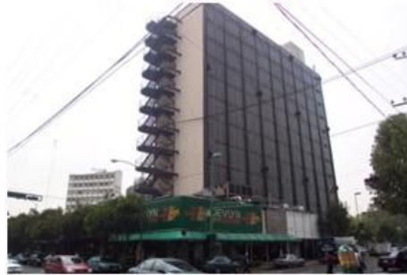
Figura 10.- Sistema de marcos de concreto contraventeados
