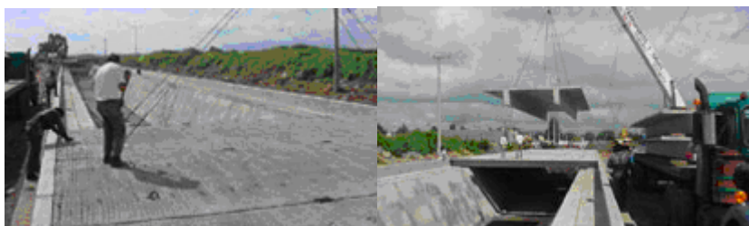
Fig. 2.12 Construcción del drenaje pluvial. (Sadasi, 2006)
