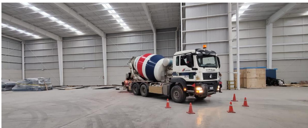
Imagen 5. Proceso de cimentación en nave industrial [9]
