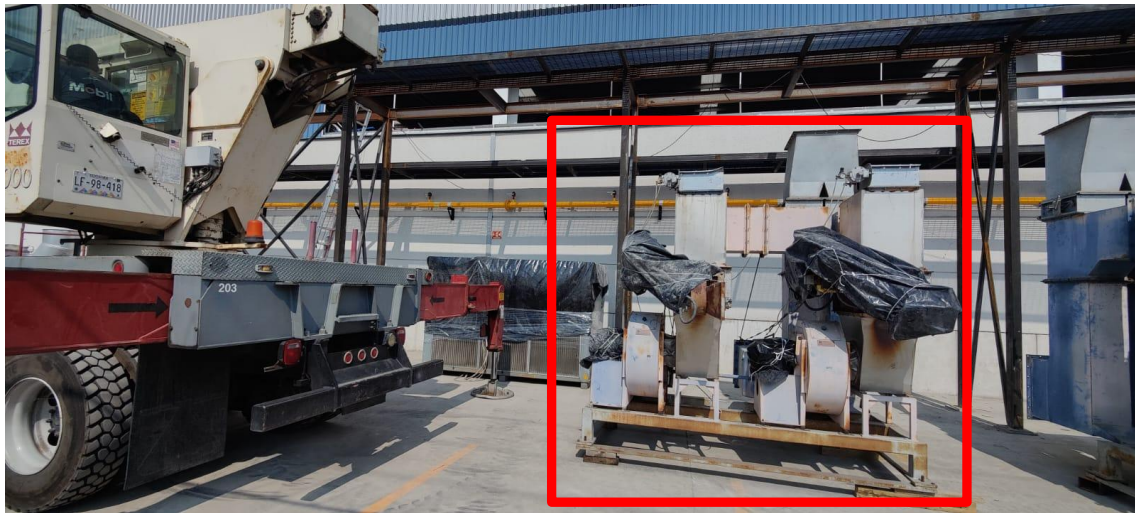
Imagen 9. Conjunto de quemadores previos a su montaje con grúa. [13]
