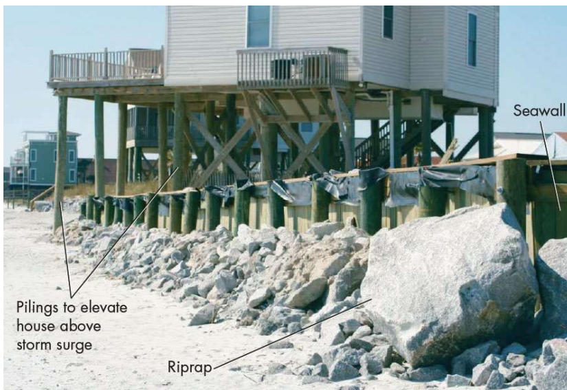
Figura 4. Para proteger sus casas de las tormentas y la erosión costera, los habitantes de la Isla Folly construyen muros de contención usando madera y grandes bloques de roca, y elevan sus viviendas sobre pilotes. En el largo plazo, estas medidas de protección también contribuyen a la erosión de la playa. Tomada de Keller y DeVecchio (2019).
