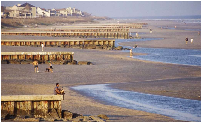
Figura 3. Los rompeolas de madera contruidos perpendicularmente a la costa favorecen la deposición de arena corriente arriba, pero también aceleran la erosión costera corriente abajo. Tomada de Keller y DeVecchio (2019).
