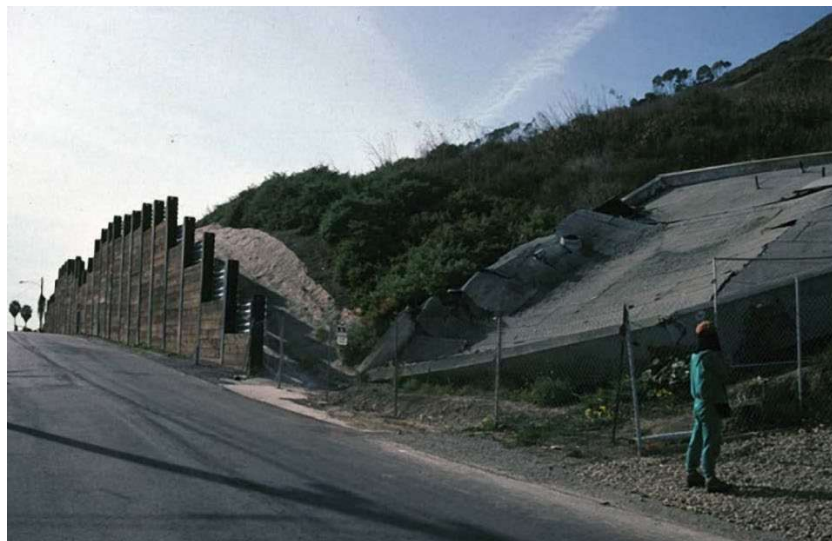
Figura 6. Este muro de contención fue construido después del deslizamiento de 1995 y fue instalado para evitar que el material suelto cubriera la carretera, pero no estaba diseñado para prevenir otro deslizamiento. Tomada de Keller y DeVecchio (2019).
