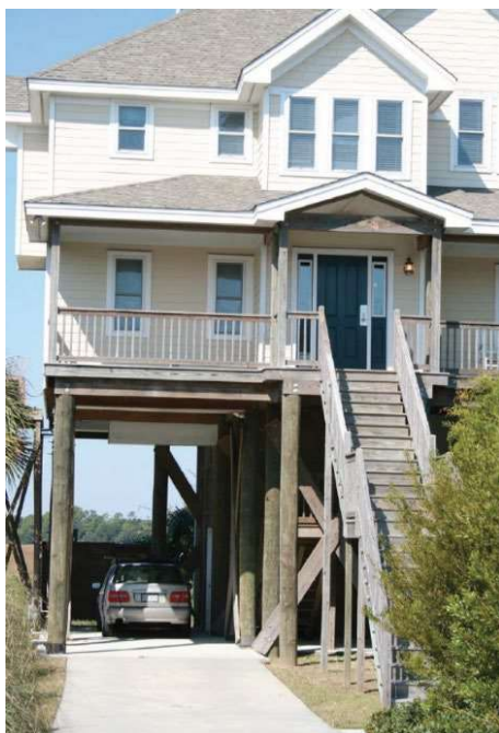
Figura 6. Con base en los mapas de riesgo de inundaciones elaborados en 2004, las nuevas viviendas en la Isla Folly se están construyendo sobre pilotes a una altura de 5 a 7 m sobre el nivel del mar. Sin embargo, considerando la continua erosión costera y el aumento del nivel del mar, esta elevación podría no ser suficiente para garantizar protección en caso de futuras marejadas ciclónicas. Imagen tomada de Keller y DeVecchio (2019).
