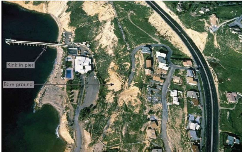
Figura 2. La deformación del muelle, visible en la parte superior izquierda de la imagen, muestra los daños iniciales causados por el deslizamiento en Portuguese Bend. Con el tiempo, la mayoría de las casas que se ven en la imagen, así como el club de natación y el muelle, quedaron destruidos por el lento movimiento del terreno. Tomada de Keller y DeVecchio (2019).
