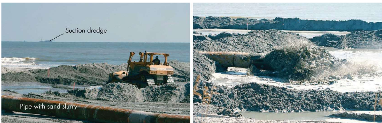
Figura 5. Para llevar a cabo el relleno artificial de las playas de la Isla Folly, se utiliza una draga hidráulica que succiona arena de la plataforma continental y la bombea hacia la costa. La mezcla de agua y arena es transportada a través de tuberías de acero, como la que se observa en primer plano en la foto a la izquierda, y una vez descargada en la playa, es nivelada y distribuida con un buldócer. Tomada de Keller y DeVecchio (2019).
