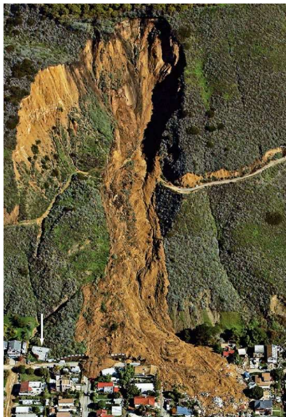
Figura 7. Vista aérea de la reactivación del deslizamiento de 1995 ocurrida en 2005. Se puede observar que el muro de contención que se había construido después del evento de 1995 quedó parcialmente enterrado y destruido. Al pie de la ladera, el deslizamiento ha formado dos flujos de tierra, uno más grande a la derecha y uno más chico hacia la izquierda. Lodo y escombros han cubierto las calles de la comunidad y dañado o sepultado alrededor de 30 casas. Tomada de Keller y DeVecchio (2019).
