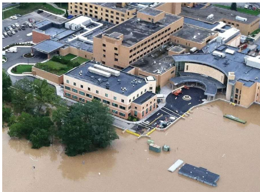
Figura 3. La instalación de barreras y puertas anti-inundación en el Centro Médico de Houston garantizó la continuidad de los servicios médicos para la población y permitió ahorrar millones de dólares en posibles daños. Tomada de Keller y DeVecchio (2019).
