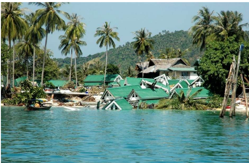
Figura 6. Daños del tsunami en una aldea en las islas Kho Phi Phi, en Tailandia ( https://www.nationalgeographic.com.es/medio-ambiente/el-tsunami-de-2004-en-el-indico-el-mas-devastador-de-la-historia_19081 ).
