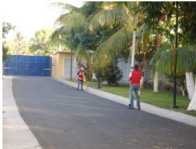
Imagen 1: Proceso de nivelación dentro de la BOGM.
