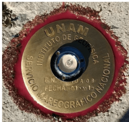
Figura 3.4: Banco de nivel instalado, nivelado y orientado al Norte en Puerto Ángel, Oaxaca.
