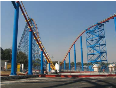
FOTOGRAFÍA 08 ZONAS 'B', 'C' Y 'D' AL FRENTE A LA IZQUIERDA ASCENSO A PRIMERA VUELTA Y A LA DERECHA ESCALERAS DE SERVICIO AL FONDO TORRES DE ASCENSO, CORONA E IMPULSO
