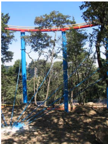
FOTOGRAFÍA 15 ZONA 'F' COLUMNAS CON TENSORES
