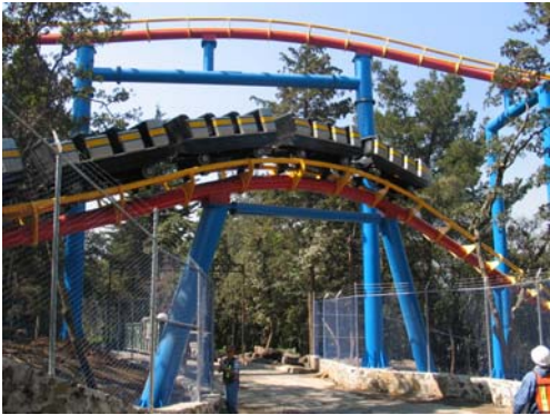
FOTOGRAFÍA 04 AL FRENTE ZONA 'A' COLUMNAS 8 Y 9 AL FONDO ZONA 'F' COLUMNAS 204, 205 Y 206
