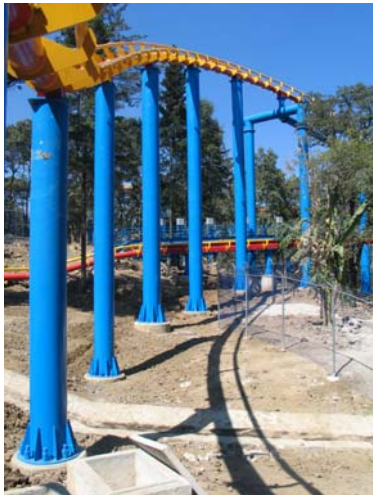
FOTOGRAFÍA 14 ZONAS 'A' Y 'F' AL FONDO COLUMNAS 193, 194, 195 Y SECCIÓN DE FRENADO A
