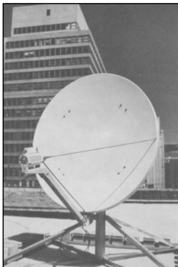
Fig. 2-3. ODU para una estación VSAT. [2]
