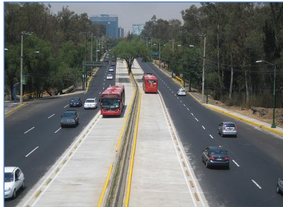
Figura 1.4. Carriles confinados de Metrobús, Ciudad de México
