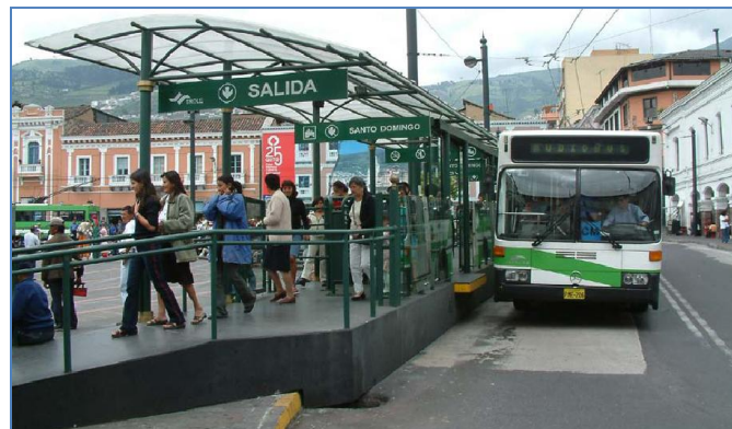
Figura 1.5. Estación de piso alto, BRT Quito, Ecuador
