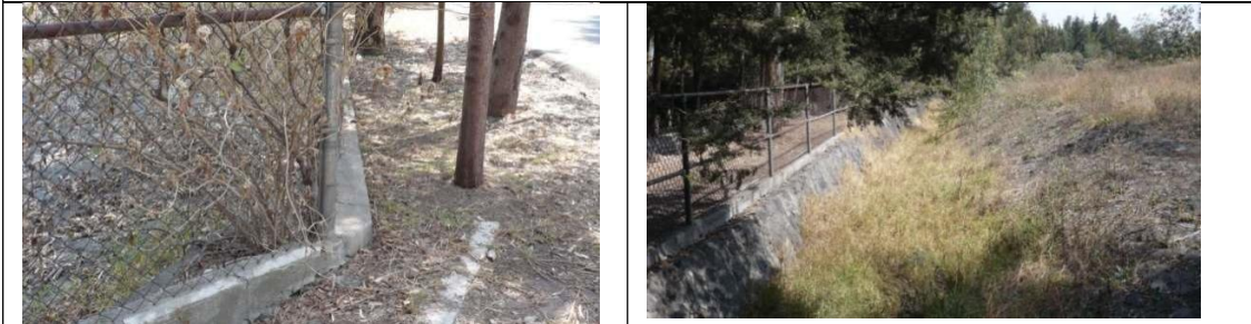
Foto 3.11. Acceso al venadario, BT.
