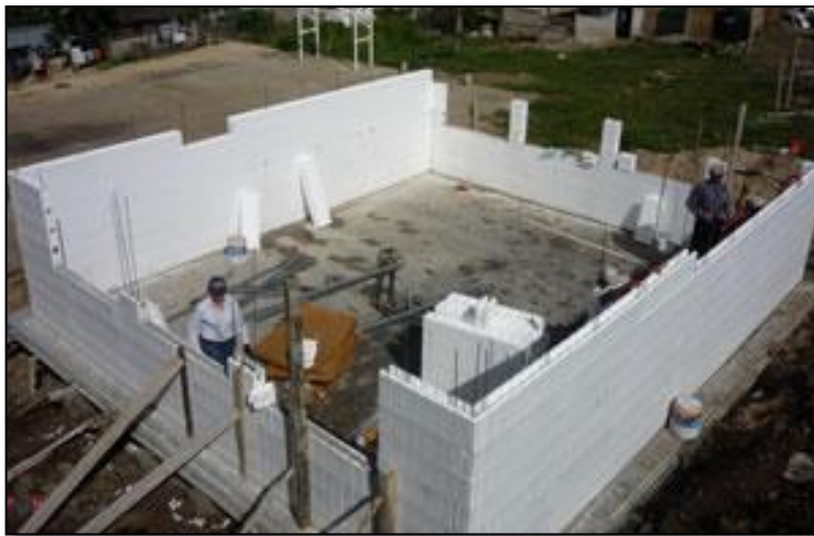
FOTOGRAFÍA 4. Levantamiento con muros ICF
