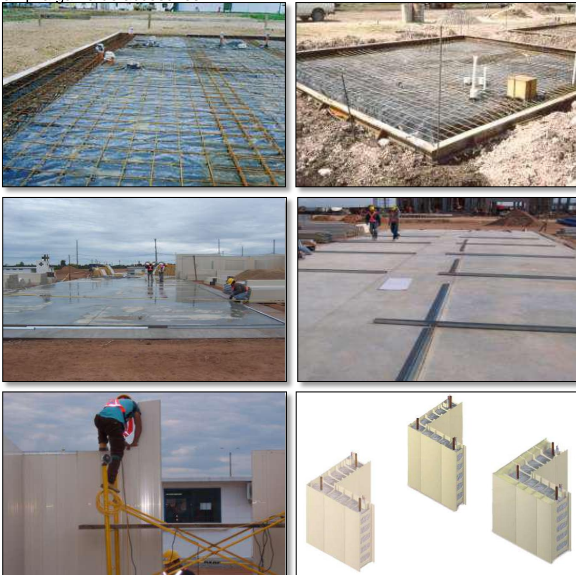
FOTOGRAFIA 7 a), b), c), d), e) y f) Distintas etapas en el proceso de cimentación
