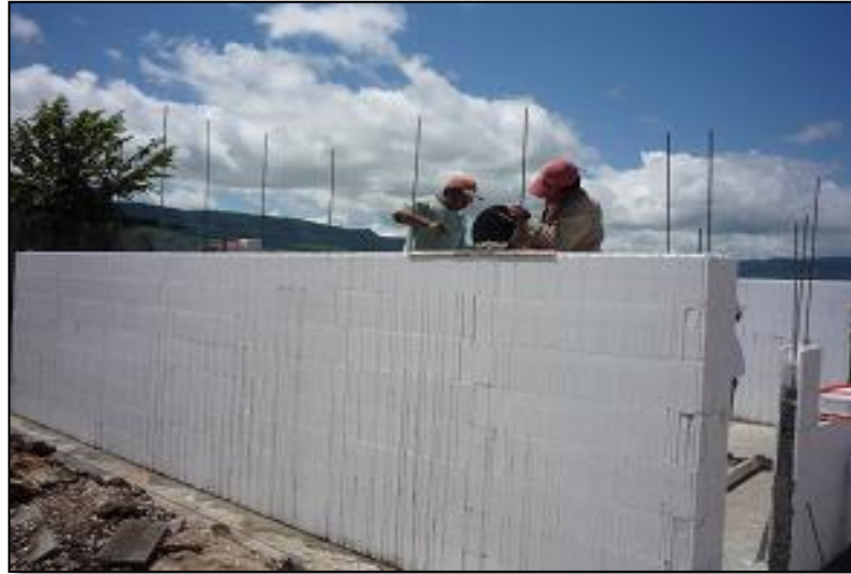
FOTOGRAFÍA 5. Armado y colado de muros ICF
