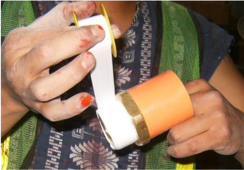
(Preparación de conector de transición de tubería Dyna flow a Blazemaster, sistema de protección contra incendio hotel Aeropuerto- Ciudad de México, tomada por el autor)
