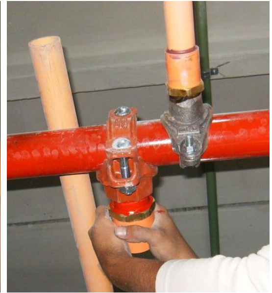
(Preparación de conector de transición de tubería Dyna flow a Blazemaster, sistema de protección contra incendio hotel Aeropuerto- Ciudad de México, tomada por el autor)
