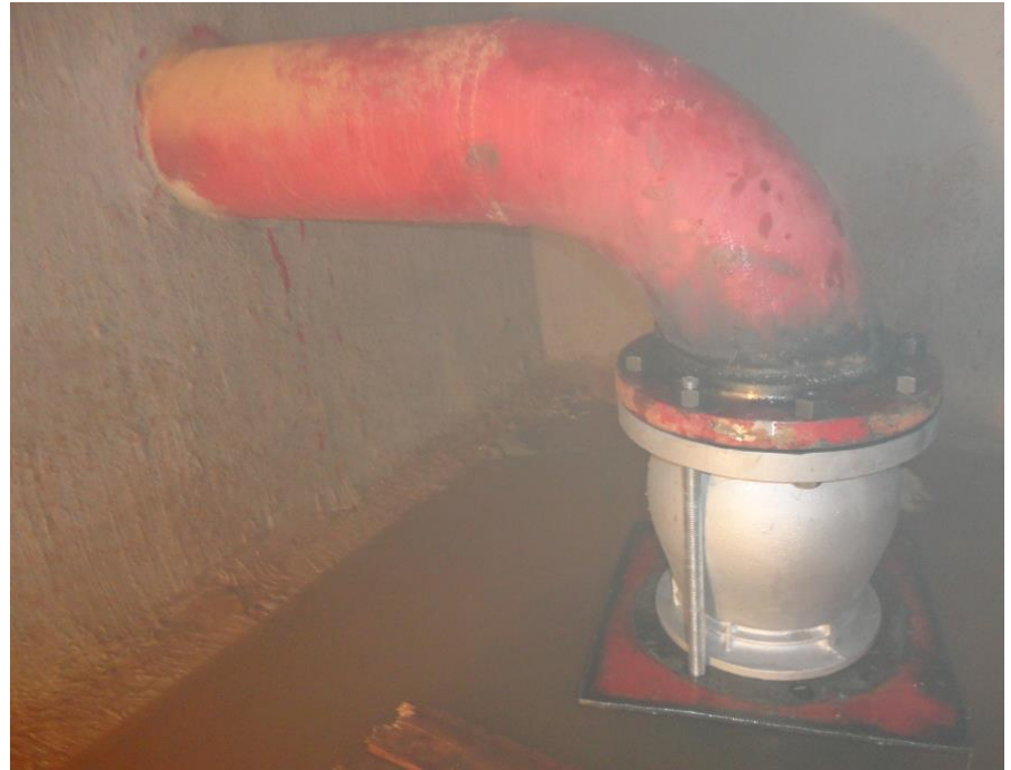
(Antes y después en el cabezal de succión del sistema de protección contra incendio hotel Aeropuerto- Ciudad de México, tomada por el autor)
