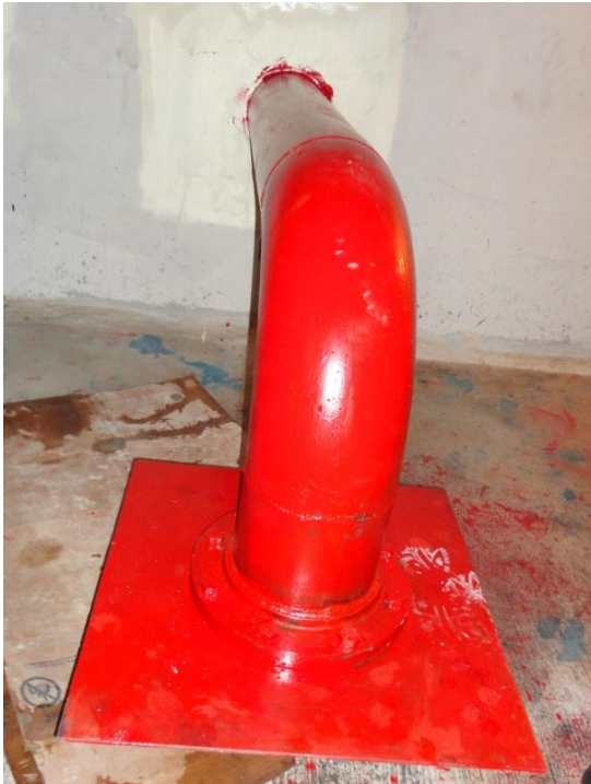
(Antes y después en el cabezal de succión del sistema de protección contra incendio hotel Aeropuerto- Ciudad de México, tomada por el autor)
