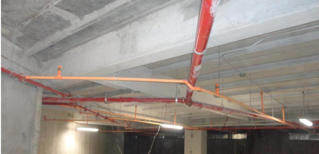
(Arreglo de tubería en malla en sótano 2, sistema de protección contra incendio hotel Aeropuerto- Ciudad de México, tomada por el autor)
