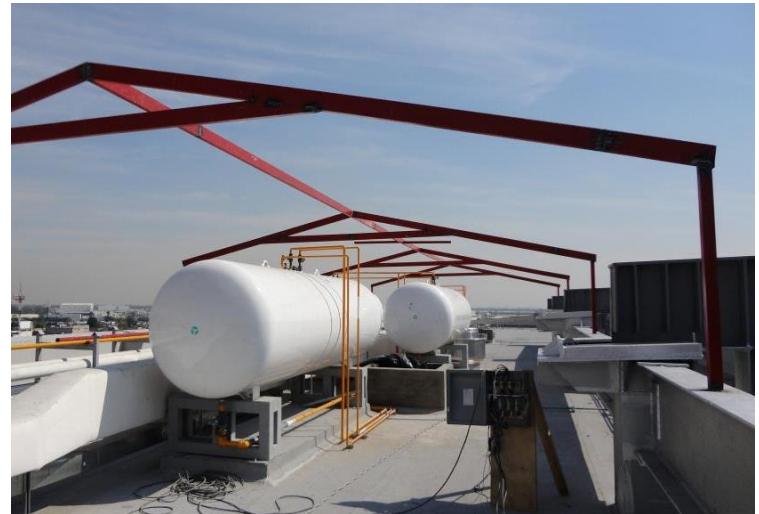
(Estructuras fabricadas en obra para el soporte del cabezal de descarga en sótano 2 y el cabezal de protección para tanques de gas en azotea, sistema de protección contra incendio hotel Aeropuerto- Ciudad de México, tomada por el autor)
