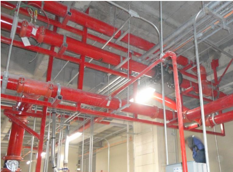
(Estructuras fabricadas en obra para el soporte del cabezal de descarga en sótano 2 y el cabezal de protección para tanques de gas en azotea, sistema de protección contra incendio hotel Aeropuerto- Ciudad de México, tomada por el autor)
