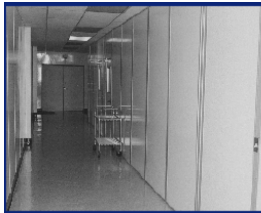
Figura 2.25 Paneles prefabricados unidos
