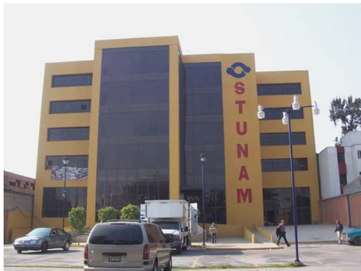
Figura 1.11 Fachada principal del edificio del STUNAM
