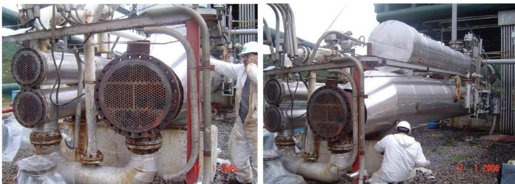
FIGURA 3.9. Mantenimiento a los intercambiadores de calor de la planta geotérmica Los Azufres (IMPULSA IV, Instituto de Ingeniería UNAM, 2008)
