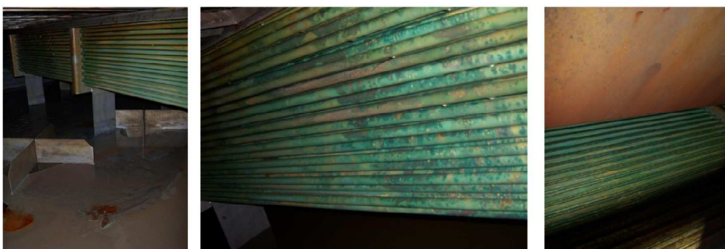
FIGURA 3. 29 Condensador de la cámara desaladora MED [IMPULSA, 2008]
