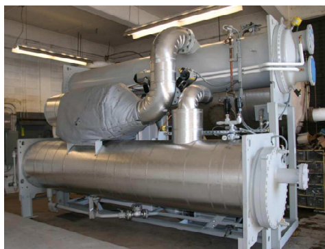
FIGURA 3. 1 Unidad modular de un ciclo binario de 280 kW. (Obtenido de United Technologies, localizada en el campus OIT).
