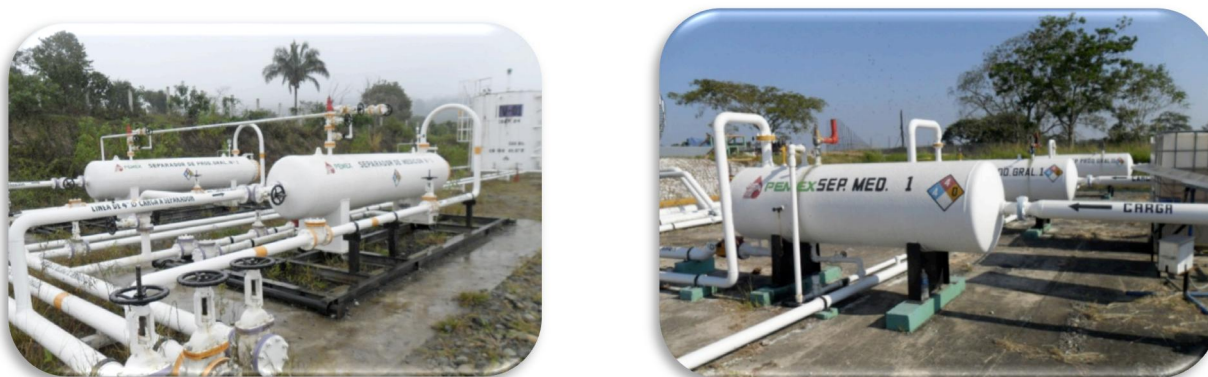
Fig. 13 Separadores de medición y de producción general
