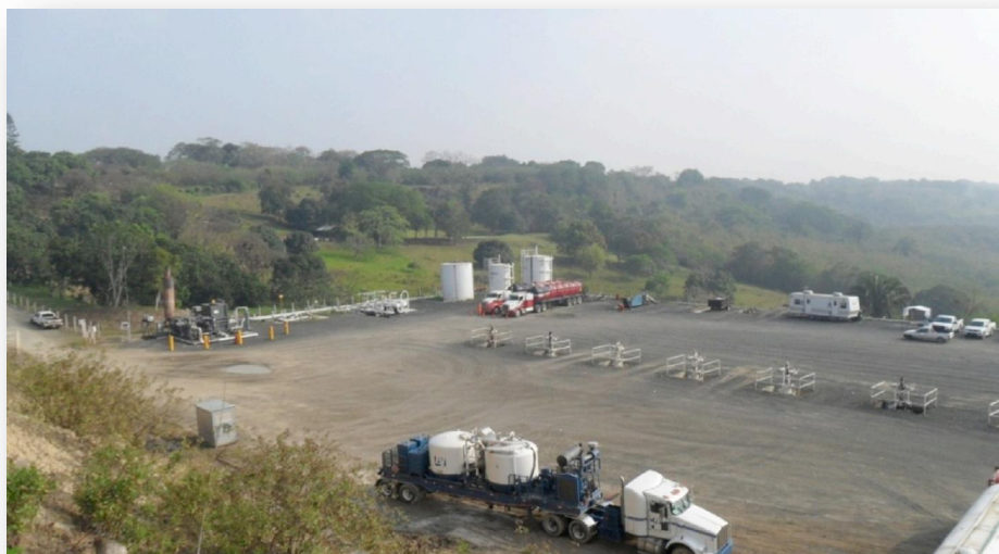
Fig. 12 Macropera del campo Chicontepec con MSP instalado
