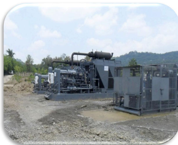
Fig. 17 Motocompresores instalados en Macroperas del campo Chicontepec.
