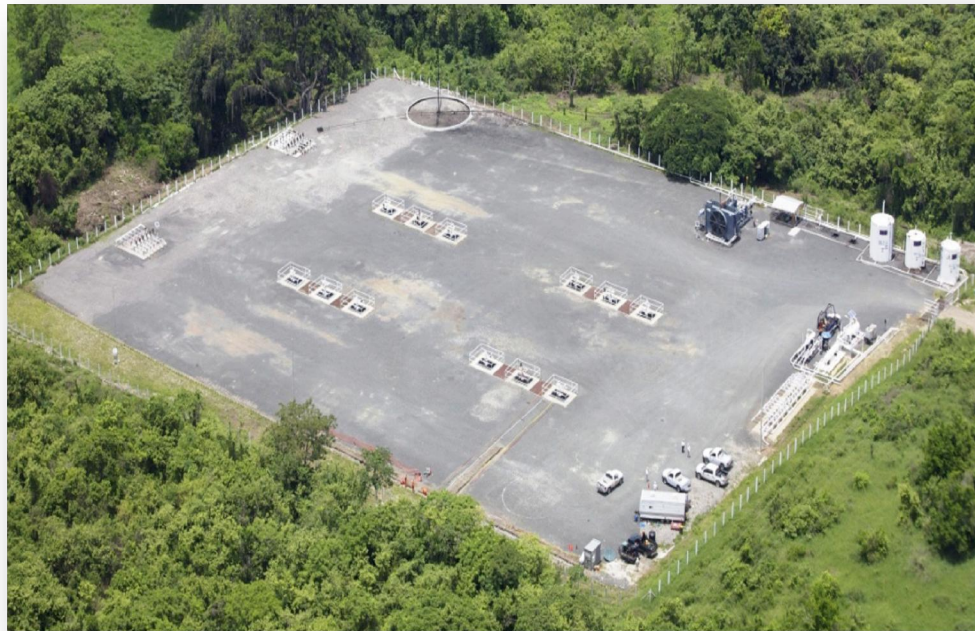
Fig. 11 Macropera del campo Chicontepec con MSP instalado
