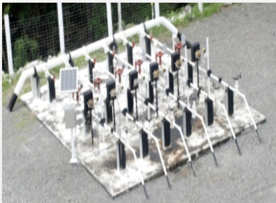
Fig. 28 Inyección de gas de BN.
