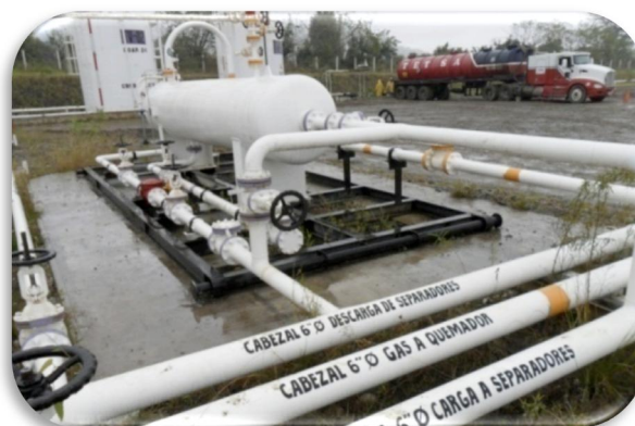
Fig. 22 Líneas de interconexión
