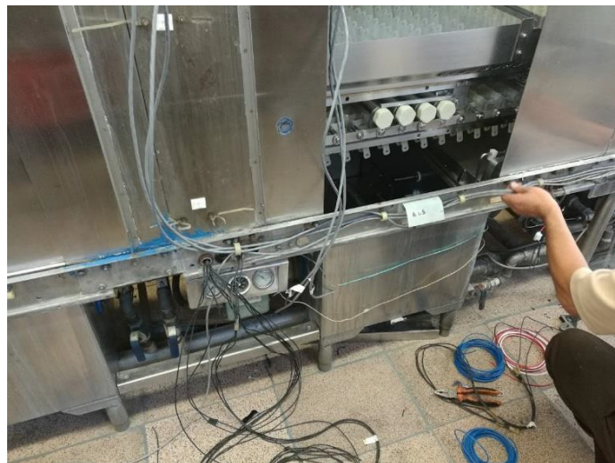
Fig. 6.37 Instalación de cableado eléctrico
