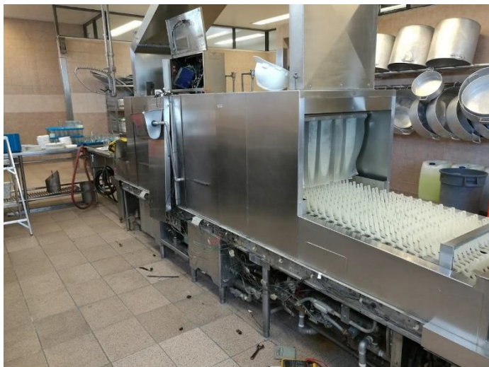
Fig. 6.32 Apertura de canaletas de conexión
