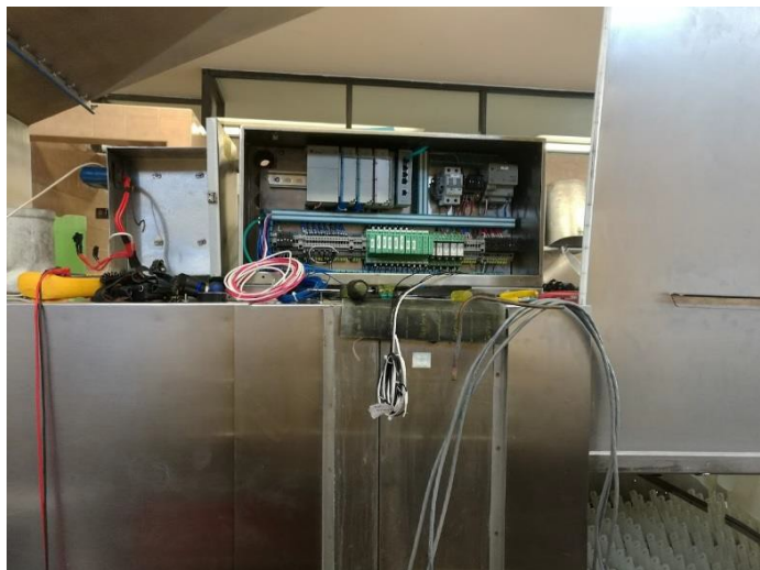
Fig. 6.36 Instalación de tableros
