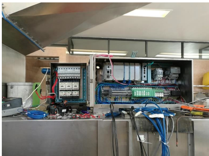
Fig. 6.38 Conexión de sensores y botones
