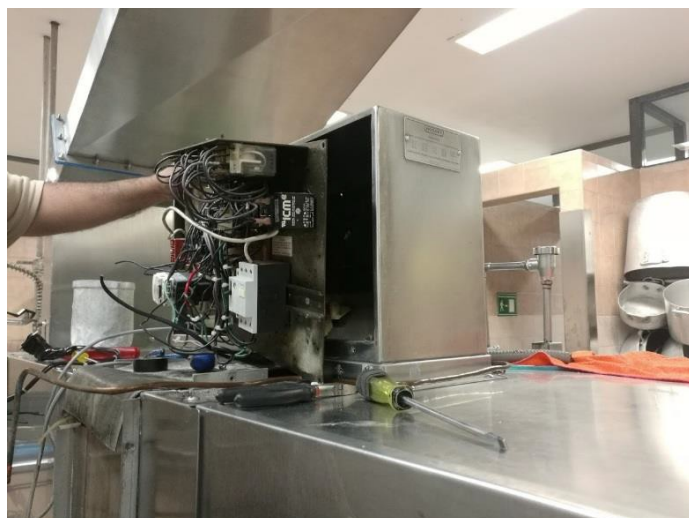
Fig. 6.34 Desmontaje de tableros
