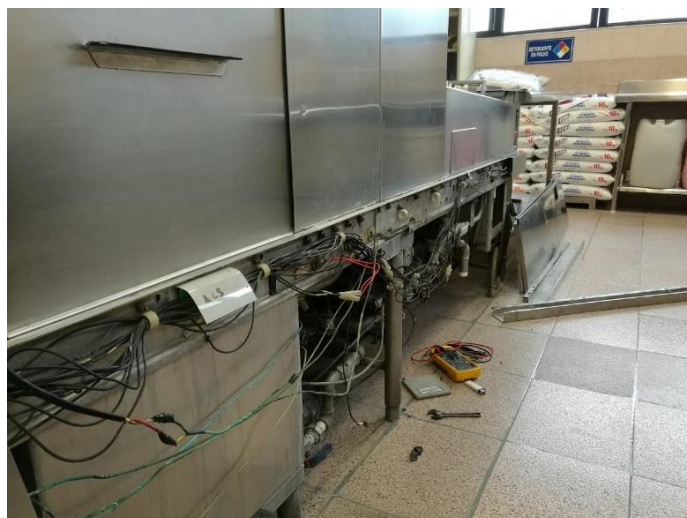
Fig. 6.35 Desmontaje de cableado eléctrico
