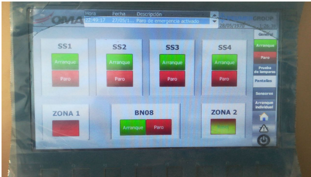
Figura 2.16: Pantalla con botones de arranque y paro por línea
