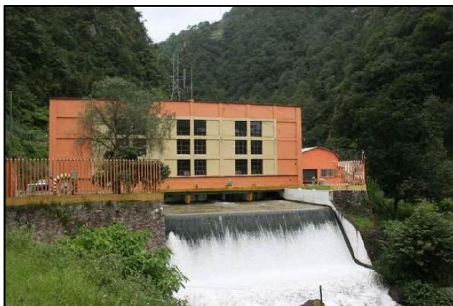
Fotografía 1.1 – Planta hidroeléctrica ‘Las Minas’
