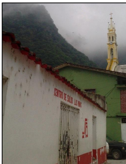
Fotografía 1.2 – Centro de salud ‘Las Minas’
