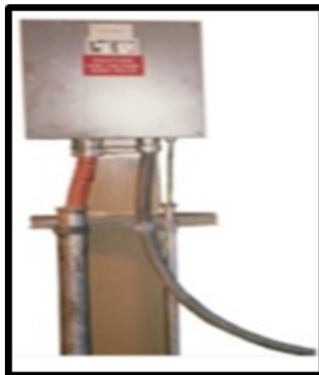
Figura 2.21: Caja de venteo.
