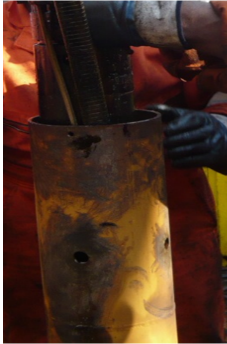
Figura 3.3: Instalación de camisa de enfriamiento.
