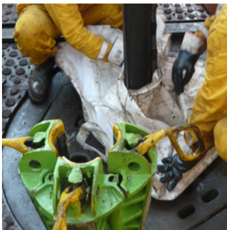
Figura 4.5: Personal colocando protección en la boca del pozo.
