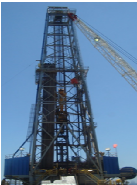
Figura 4.6: Torre de perforación.
