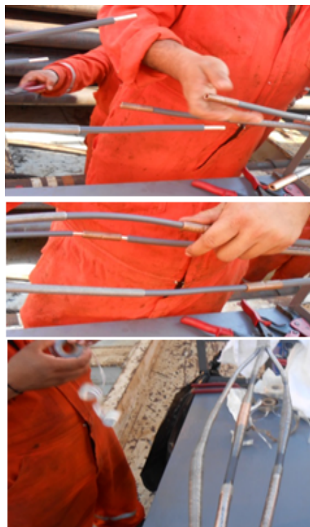
Figura 4.3: Proceso de empalme del cable de potencia.
