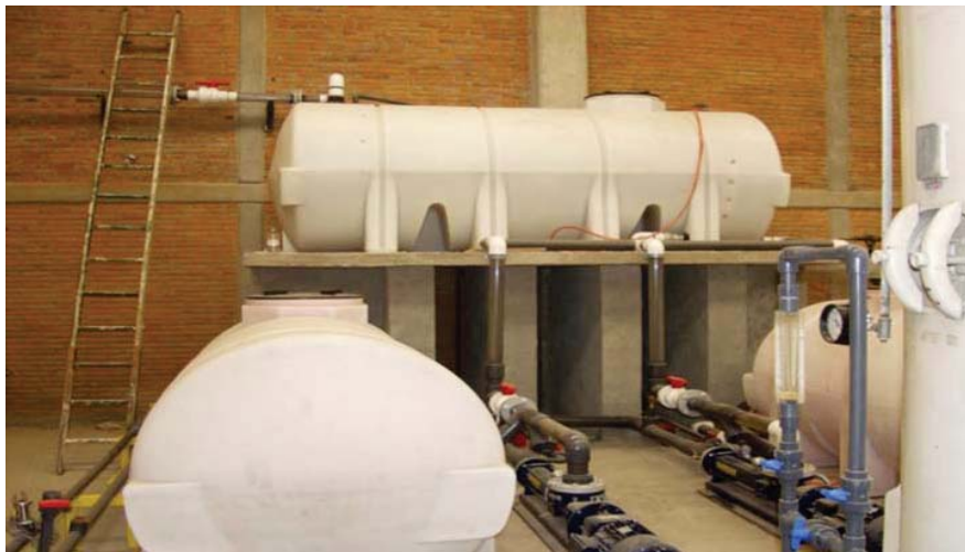
Figura 3.2: Tanque de almacenamiento del líquido (el volumen interno del tanque es de 2.8 \text{ m}^3 ).
