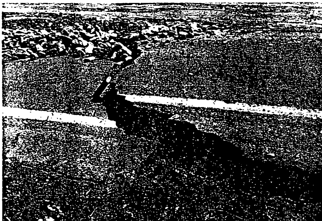
Carretera : Guadalajara – Barra de Navidad Puente : Jaluco 1; km 260+900
