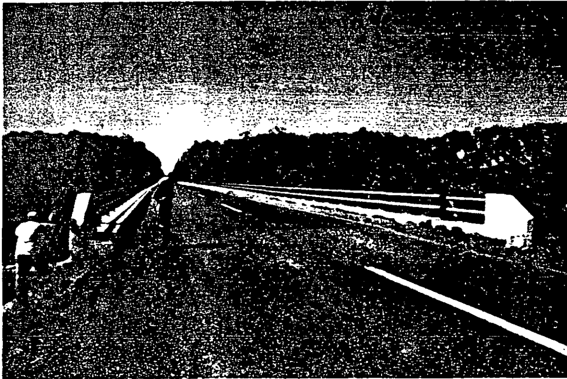
VISTA GENERAL DEL PUENTE
