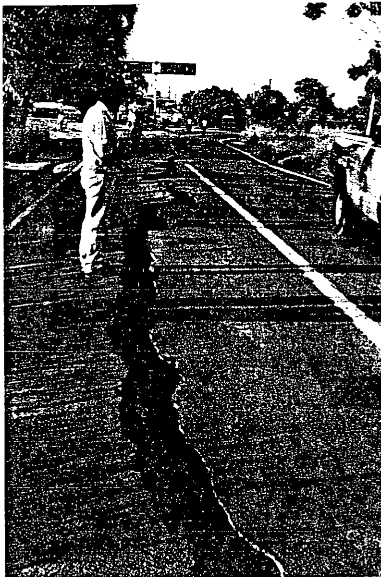
Carretera : Guadalajara – Barra de Navidad Puente : Jaluco 1; km 260+900
