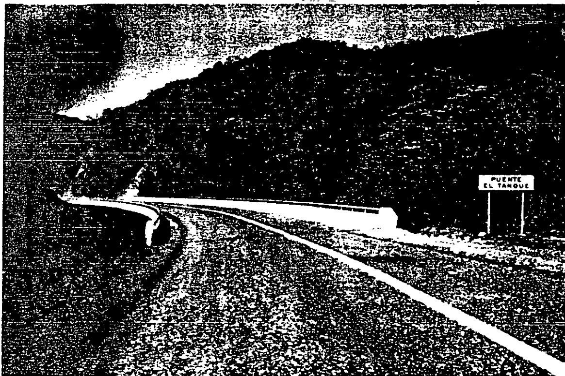
VISTA GENERAL DEL PUENTE
