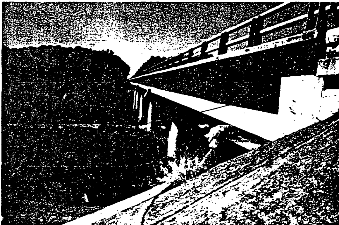
VISTA GENERAL DEL PUENTE
