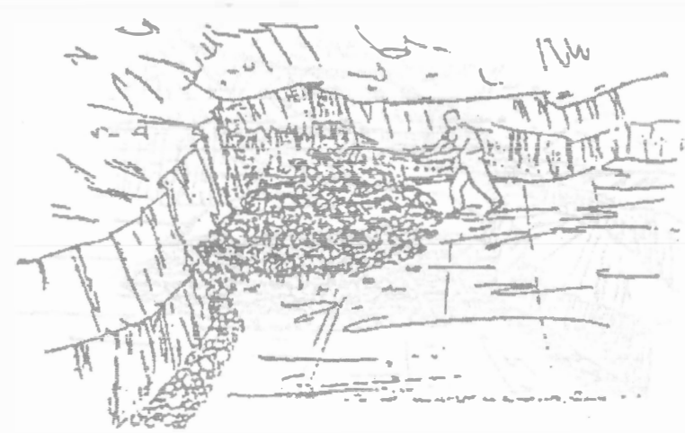
Figura 8. Esparcimiento de los desechos en el área limitada para la celda.
