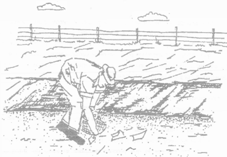
Figura 30. Recolección de material disperso en el área del relleno.
